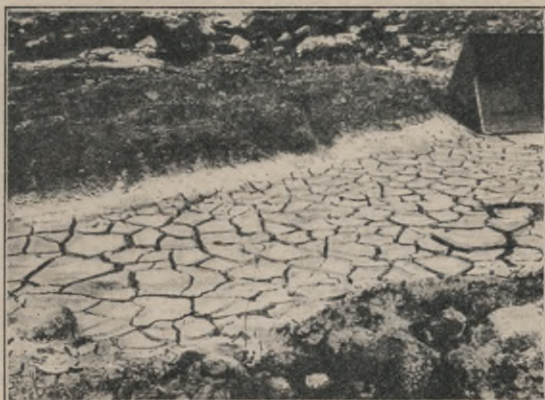
Rys. 35. Pęknięcie zysychającej się gliny osadowej.
