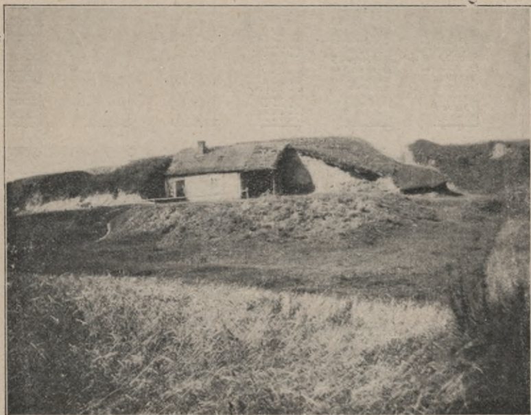
Rys. 21. Chata w pow. Opatowskim, przybudowana do prostopadłej ściany lössowej .
