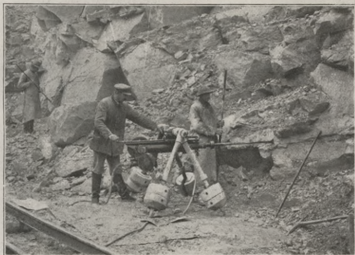
Abb. 53. Elektrisch angetriebener Bohrer im Bergbau.
