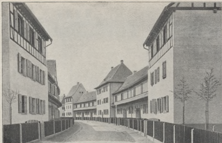
Abb. 58. Kleinhaus-Straße (5 m breit) in der Kolonie Stockfeld bei Straßburg.
