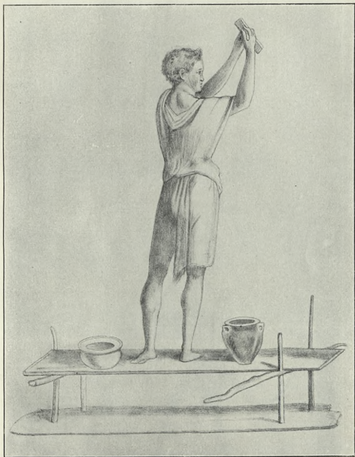
122. Maurer beim Verputzen einer Wand. (Wandbild aus Pompeii.)
