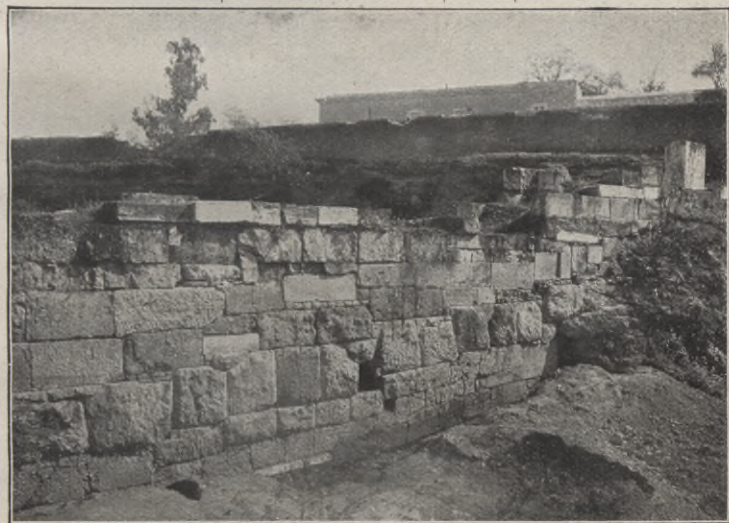
48. Teil der unter Themistokles nach 479 vor Chr. errichteten athenischen Stadtmauer. In Athen am Dipylon.
