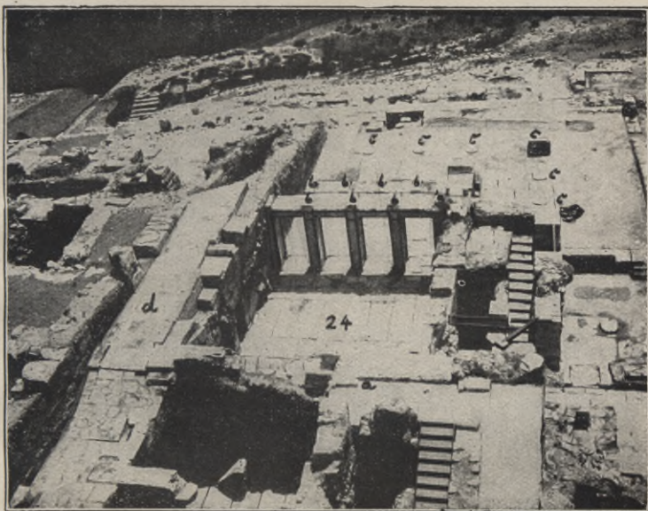
1. Teil des Palastes von Knossos, Kreta. Um 1500 vor Chr. (a Lichthof, 24 Halle der Doppeläpse, b b b zweite Halle, c c c Säulenhalle im O und S, d Korridor im ersten Stock.)
