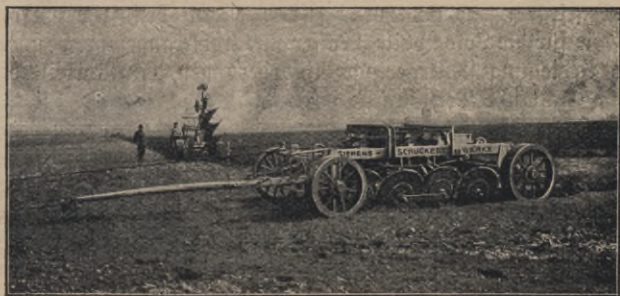
Abb. 133. Elektrisch betriebener Pflug.
