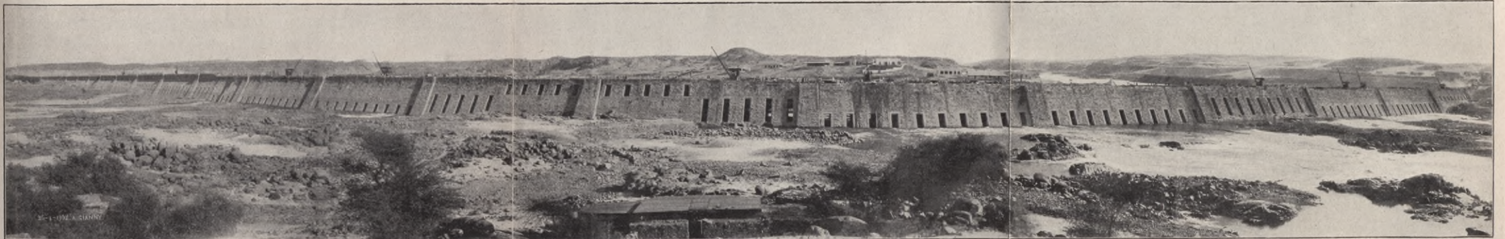
Abb. 20. Staudamm von Assuan. Totalansicht.
