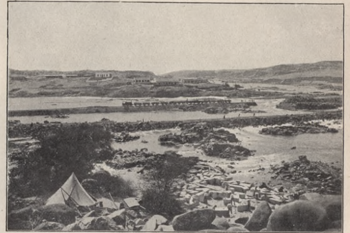
Abb. 22. Dammbau von Assuan. Die Abschlußdämme von Habb's Island gesehen.
