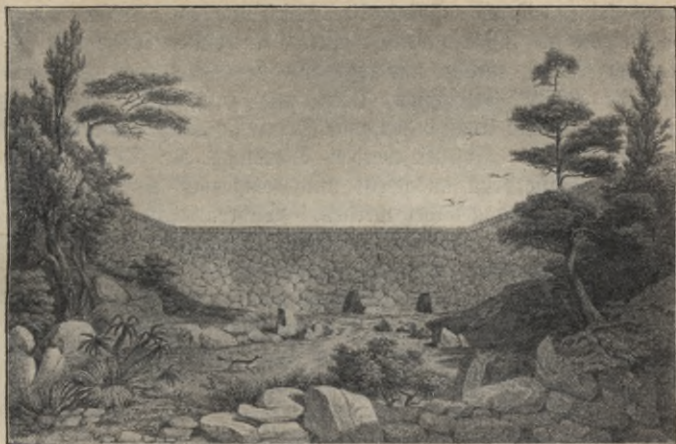
Abb. 29. Druckleitung von Patara.
