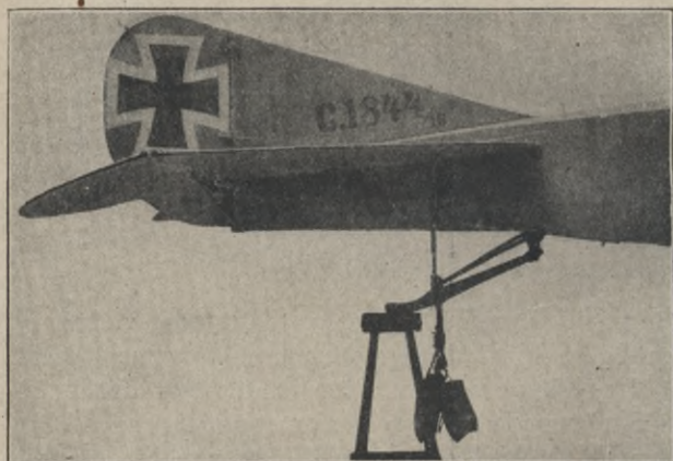
Fig. 36. Rumpf aufgebaut und beschwert.
