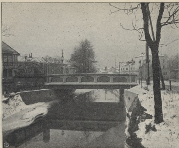
Abb. 54. Brücke über die Lockwitz in Niedersiedlitz. Straßenbrücke mit versenkter Fahrbahn.
