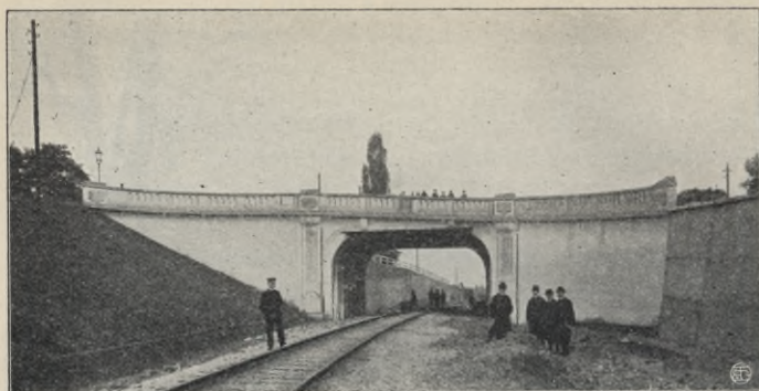
Abb. 55. Brücke über die Eisenbahn in Meerane. Straßenbrücke mit Rahmenbalken.
