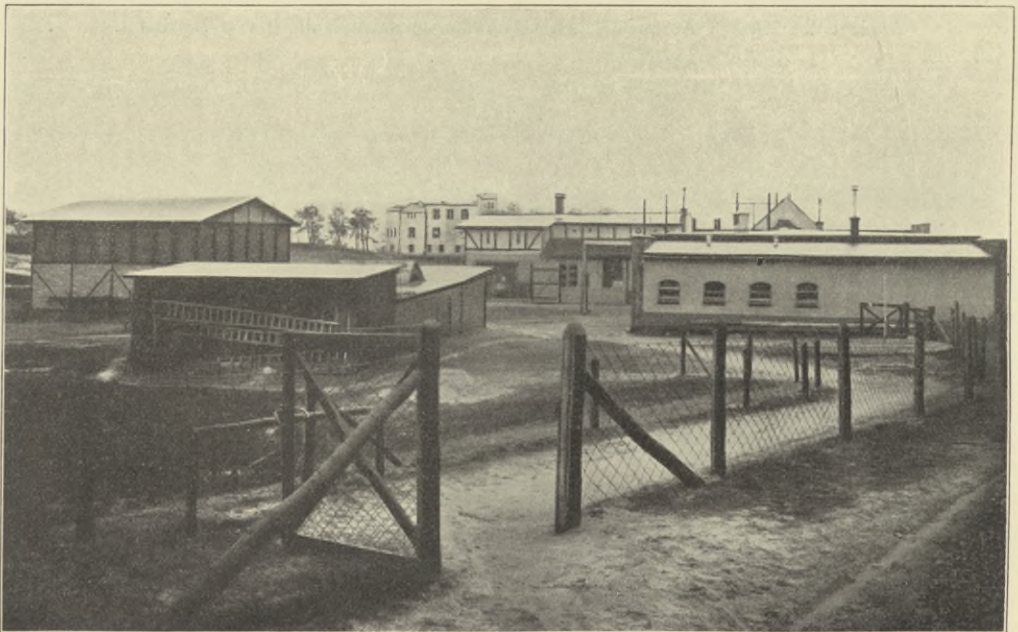
Das Maschinen- und Werkstattgebäude mit den Kohlenschuppen und dem Vorratsspeicher. Im Hintergrunde das Direktorhaus.
