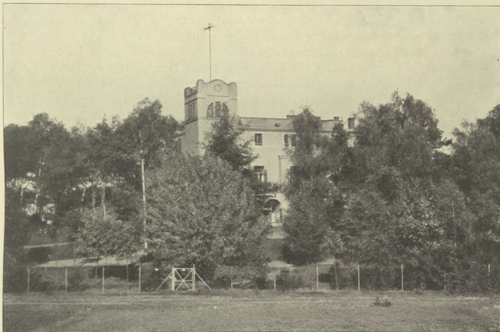
Wohnhaus des Direktors, von Südosten gesehen.
