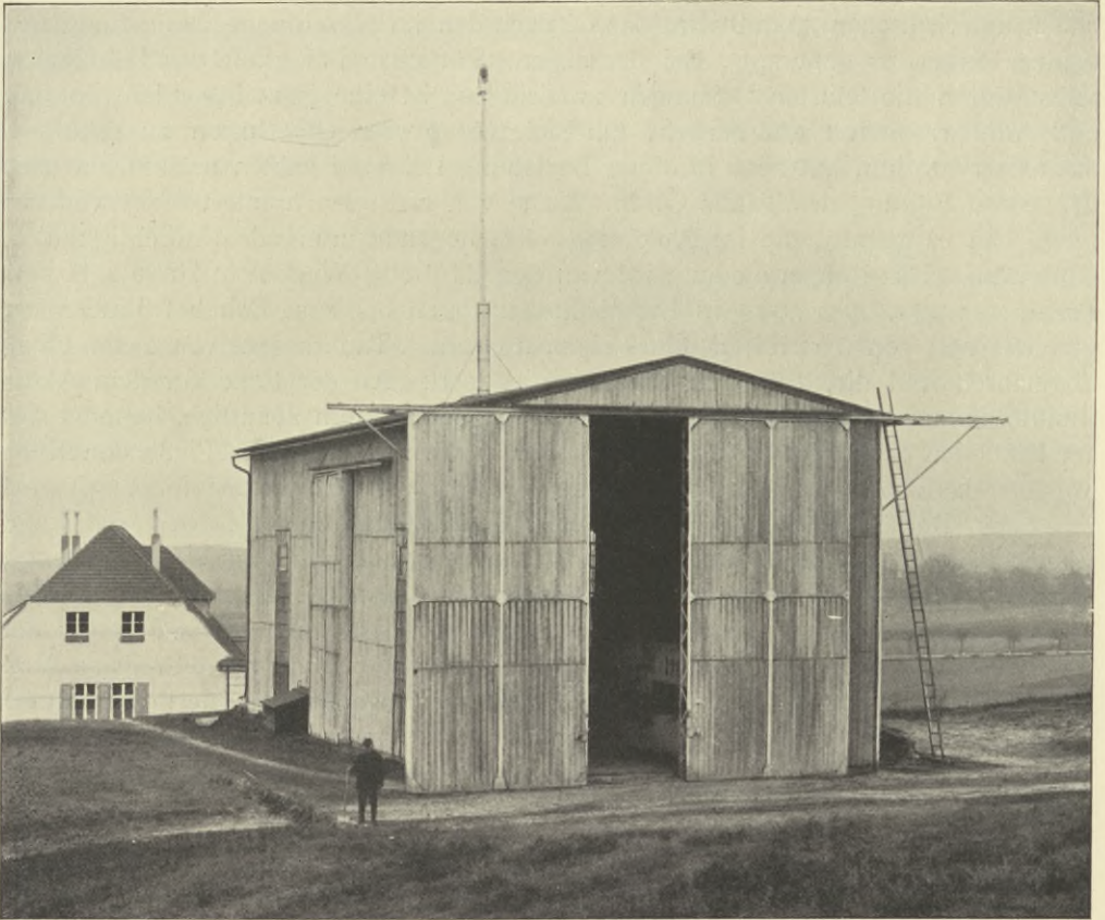
Die Ballonhalle, links der Giebel des Observatorhauses.
