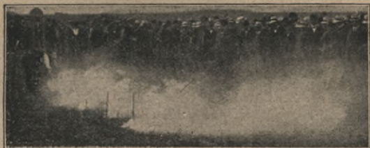
Anstecken der Zündschnüre für Baumgruben und Tieflockern des Untergrundes.
