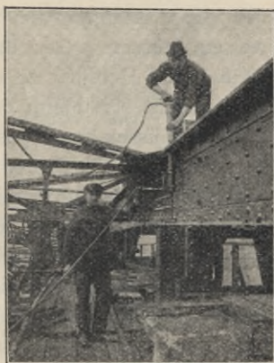
Abb. 5. Nieten mit Drucklufthammer und Druckluftgegenhalter.
