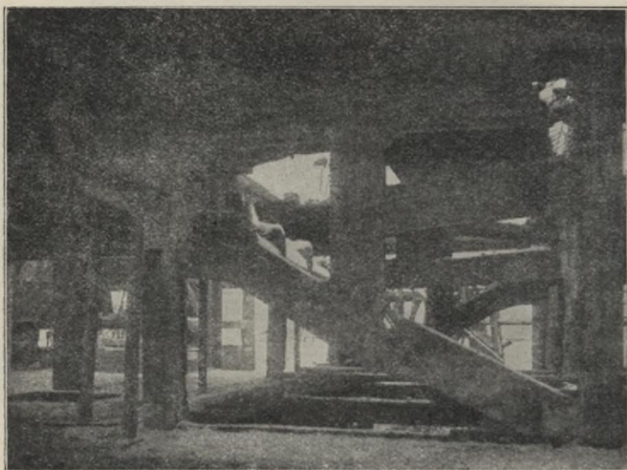
Abb. 6. Durch Auffallen schwerer Lasten gebrochene Konstruktionsteile.
