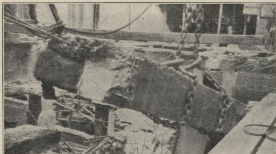
Abb. 2. Abgeschnittene Hauptunterzüge werden an Ketten empor-
