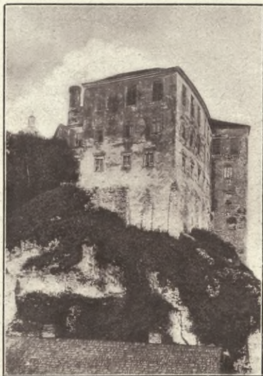
Zamek w Pieskowej Skale. Część zachodnia.
