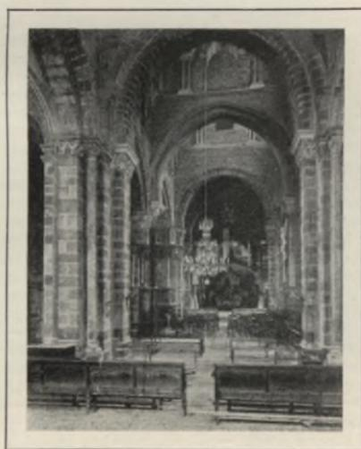
Abb. 217. Le Puy, Notre-Dame. Schiff. Lanzettgurtbogen Trompenkuppeln tragend. (Vergl. Abb. 66.)
