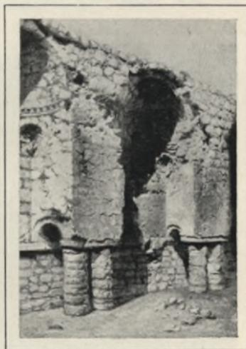
Abb. 24. Palast von Sarvistan, Galerie C (Abart γ'). Tonnengewölbe. Strebepfeiler auf Säulen. Trompenhalbkuppeln.
