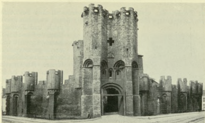
1. — Gent, Grafenschloß (1180). Heutige Gesamtansicht nach der Wiederherstellung.
