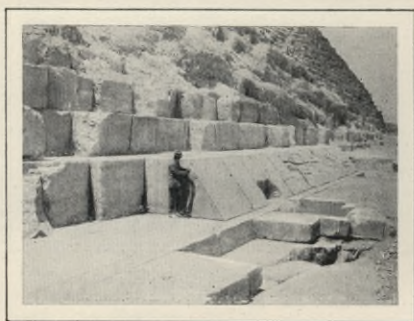
Abb. 75. Die unterste Lage von der Bekleidung der großen Pyramide.
