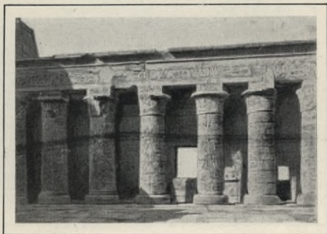
Abb. 275. Fassade vom Palast des Ramses III. im ersten Hof des Tempels von Medinet-Habu.
