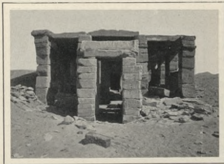
Abb. 244. Zerstörte Fassade des Tempels von Amada.
