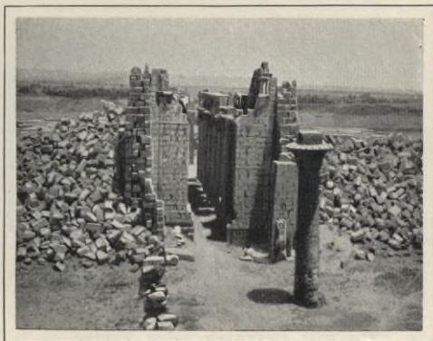
Abb. 412. Reste vom Vorbau des Taharka in Karnak.
