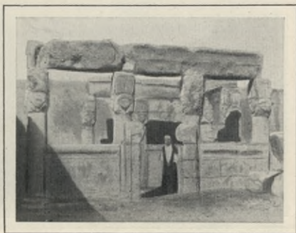
Abb. 420. Gebäude auf dem Dach des Hathor-Tempels in Dendera.
