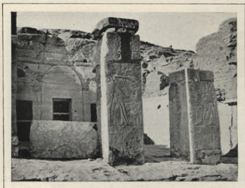
Abb. 256. Fassade des Hemispeos von Bêt-el-Wâly.
