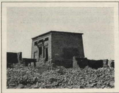
Abb. 443. Der Tempel von Taffe vor der Restaurierung.
