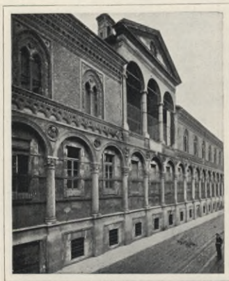
Abb. 294. Mailand, Der alte Teil des Ospedale Maggiore. (Brogi)
