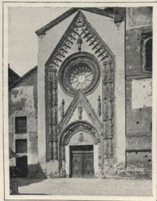
Abb. 475. Chivasso, Fassade des Doms. (Alinari)
