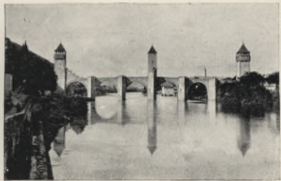
Abb. 180. Cahors, Valentré-Brücke. (Phot. Neurdein)
