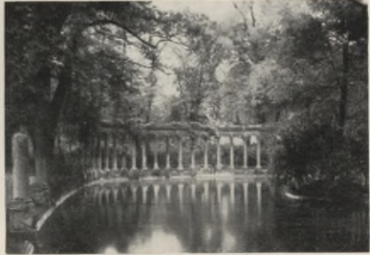
Abb. 590. Paris, Die Kolonnade im Parc Monceau. (Phot. Hachette)
