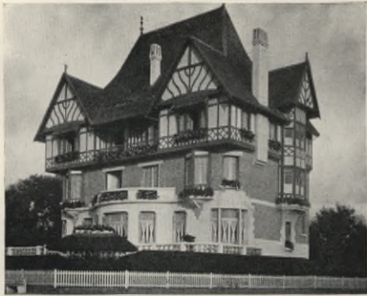
Abb. 769. A. Bluysen, Villa am Meer. (Phot. „l'Architecte“)
