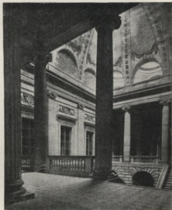
Abb. 595. V. Louis, Treppenhaus im Stadttheater zu Bordeaux. (Phot. L'Architecte)
