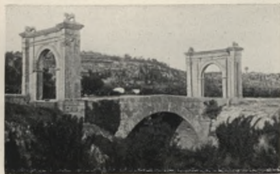
Abb. 5. Brücke zu Saint-Chamas. (Phot. Gouzy)
