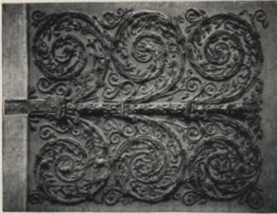
Abb. 158. Eisernes Türband, mittelst Gesenken geschmiedet, an Notre-Dame zu Paris. (Phot. Hachette)
