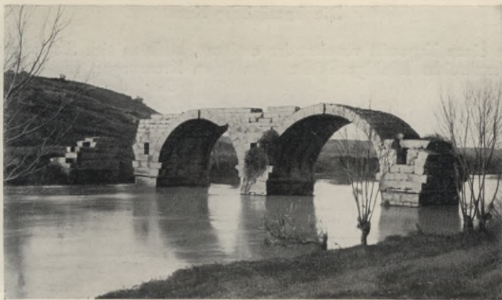
Abb. 1. Römische Brücke über den Vidourle bei Lunel. (Phot. Gouzy)
