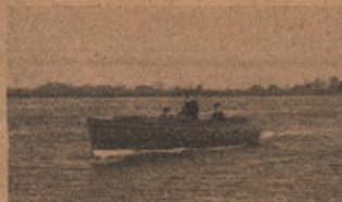
Offenes Boot mit 20 P. S.-Motor Länge 11 Meter, Breite 2 Meter Geschwindigkeit 19,2 km.
