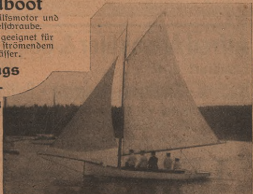
Offenes Boot mit 20 P. S.-Motor Länge 11 Meter, Breite 2 Meter Geschwindigkeit 19,2 km.
