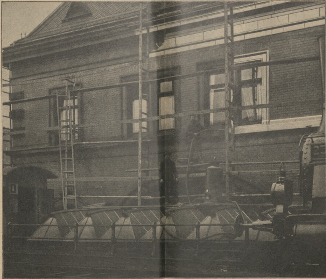
Fig. 105. Sandstrahlgebläse „Alpha“ beim Reinigen von Fassaden. Die Betriebskraft wird hier von einer Lokomotive geliefert
