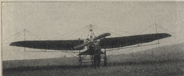
Fig. 57. Etrich-Taube mit Schwade-Rotationsmotor.
