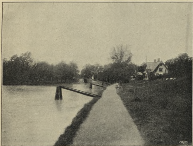
Fig. 2. Brinkebergskulle med övre slussen, före ombyggnadsarbetenas påbörjande.
