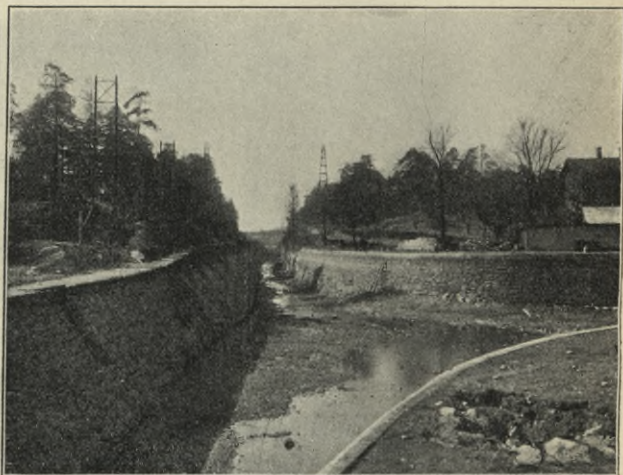
Fig. 16. Bergkanalen vid Nydqvist & Holms hamnbassäng, före ombyggnaden.
