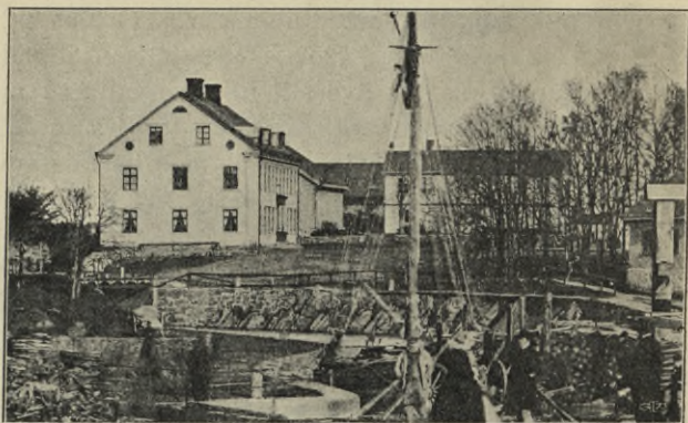
Fig. 4. Dragbro vid Trollhättan år 1863.
