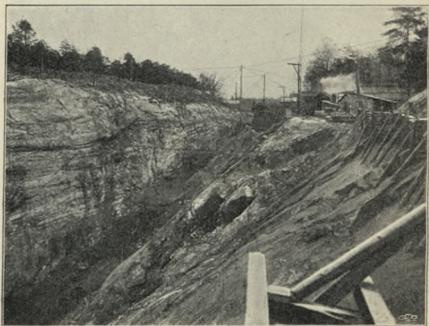
Fig. 18. Bergschakt för slusstrappan vid Holmen.
