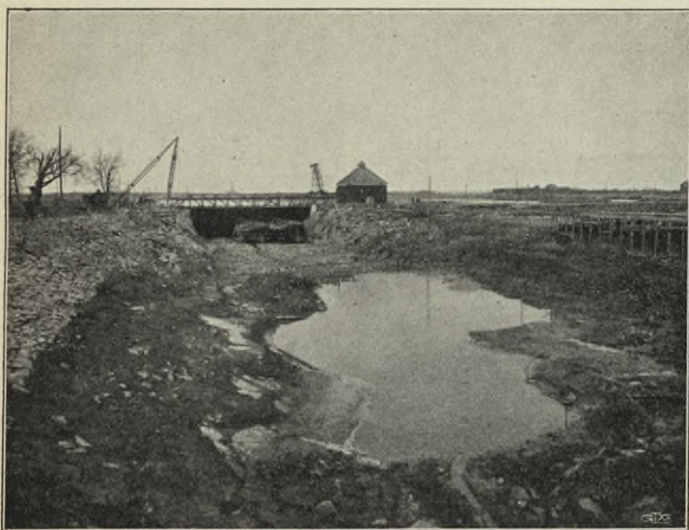
Fig. 29. Avstängningsanordning i Karlsgrav vid Fridhem.
