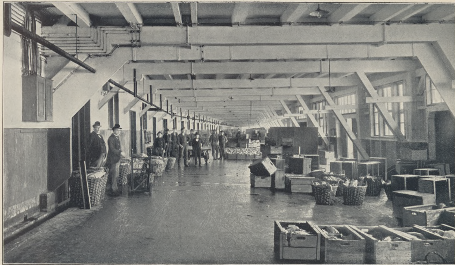
Teil der Fischauktionshalle am Fischereihafen zu Geestemünde.
