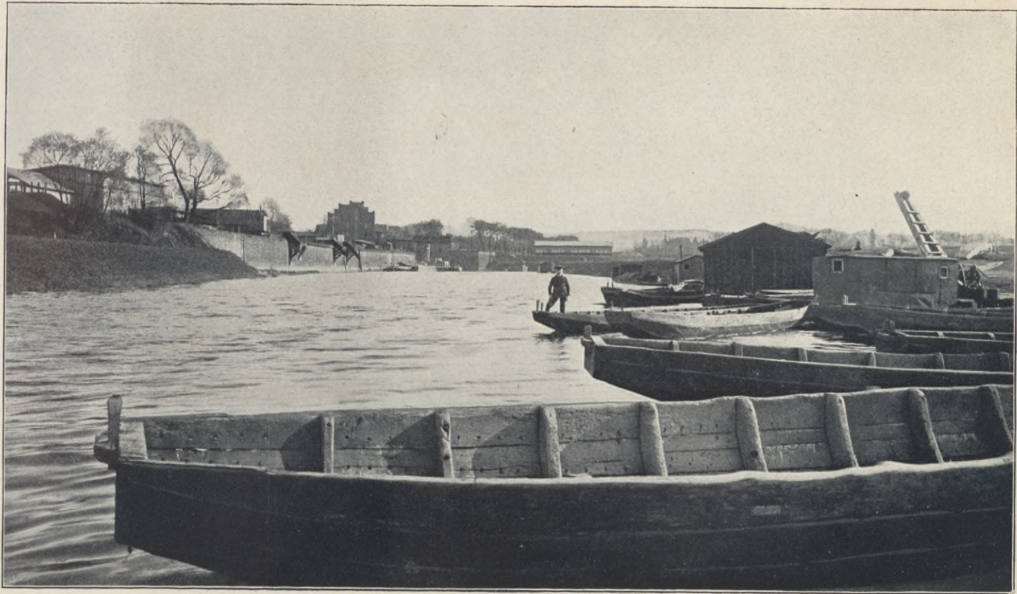
Hafen in Minden mit Umschlagseinrichtungen.
