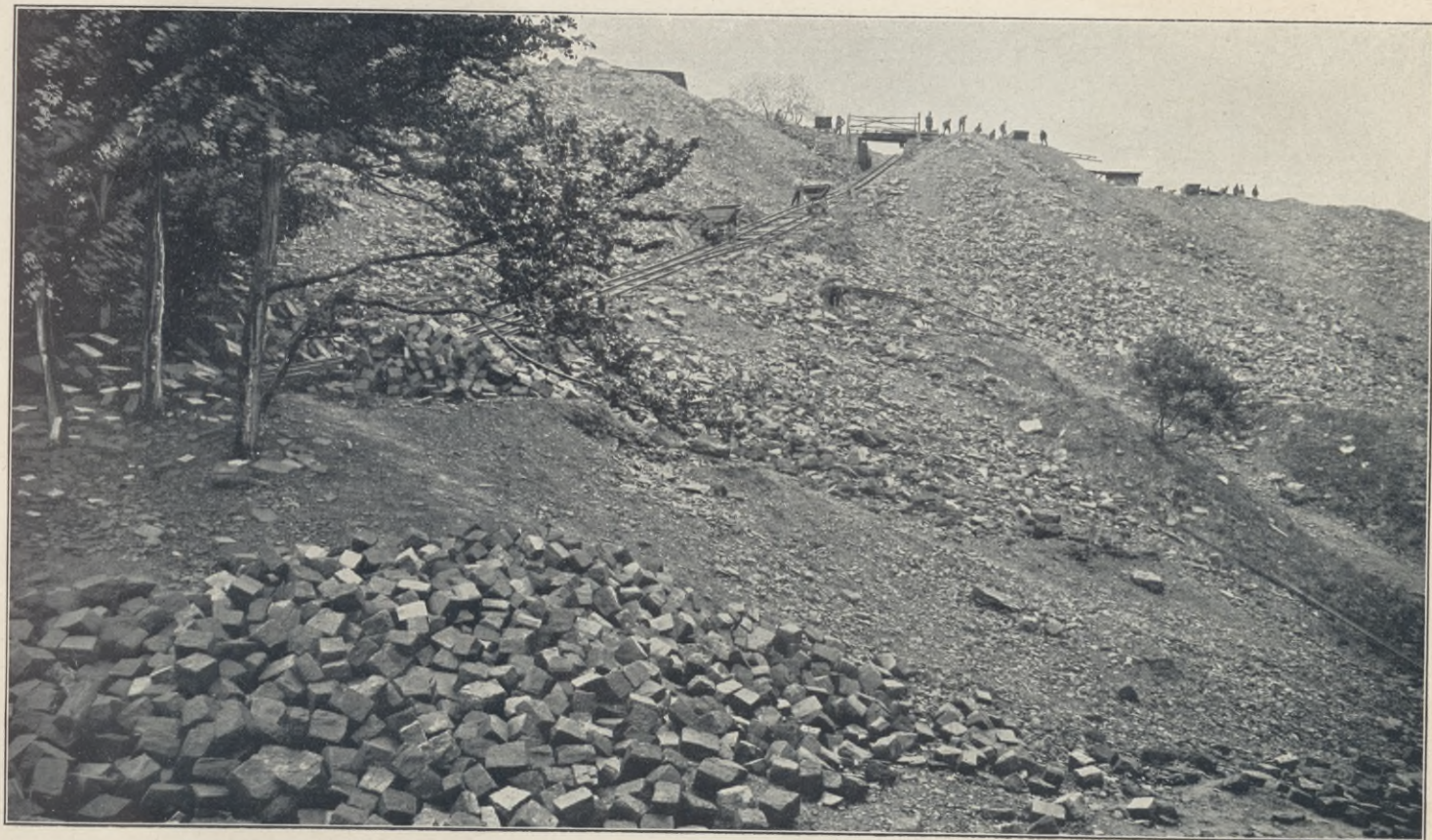
Steinbrüche von E. Warnecke, Carlshafen.
