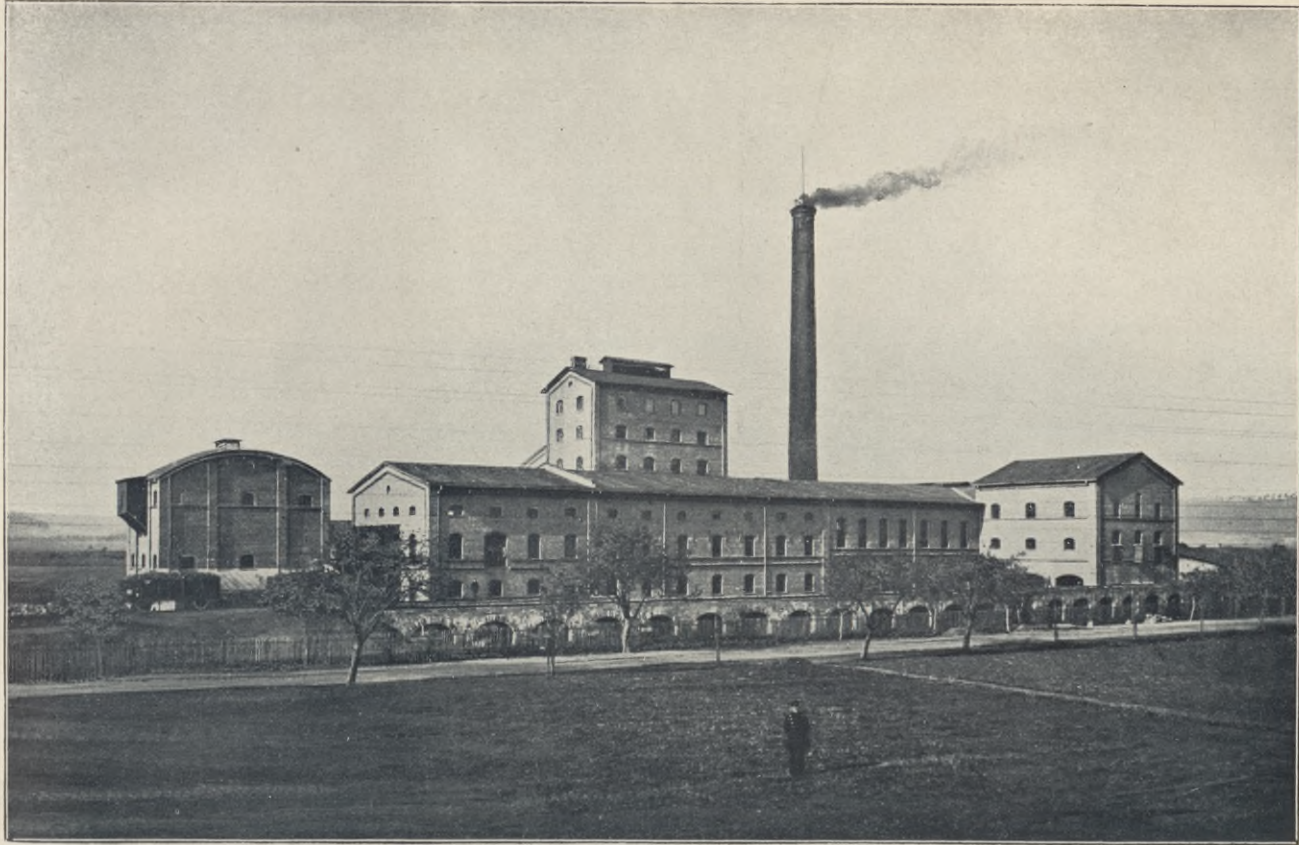
Zuckerfabrik in Holzminden.
