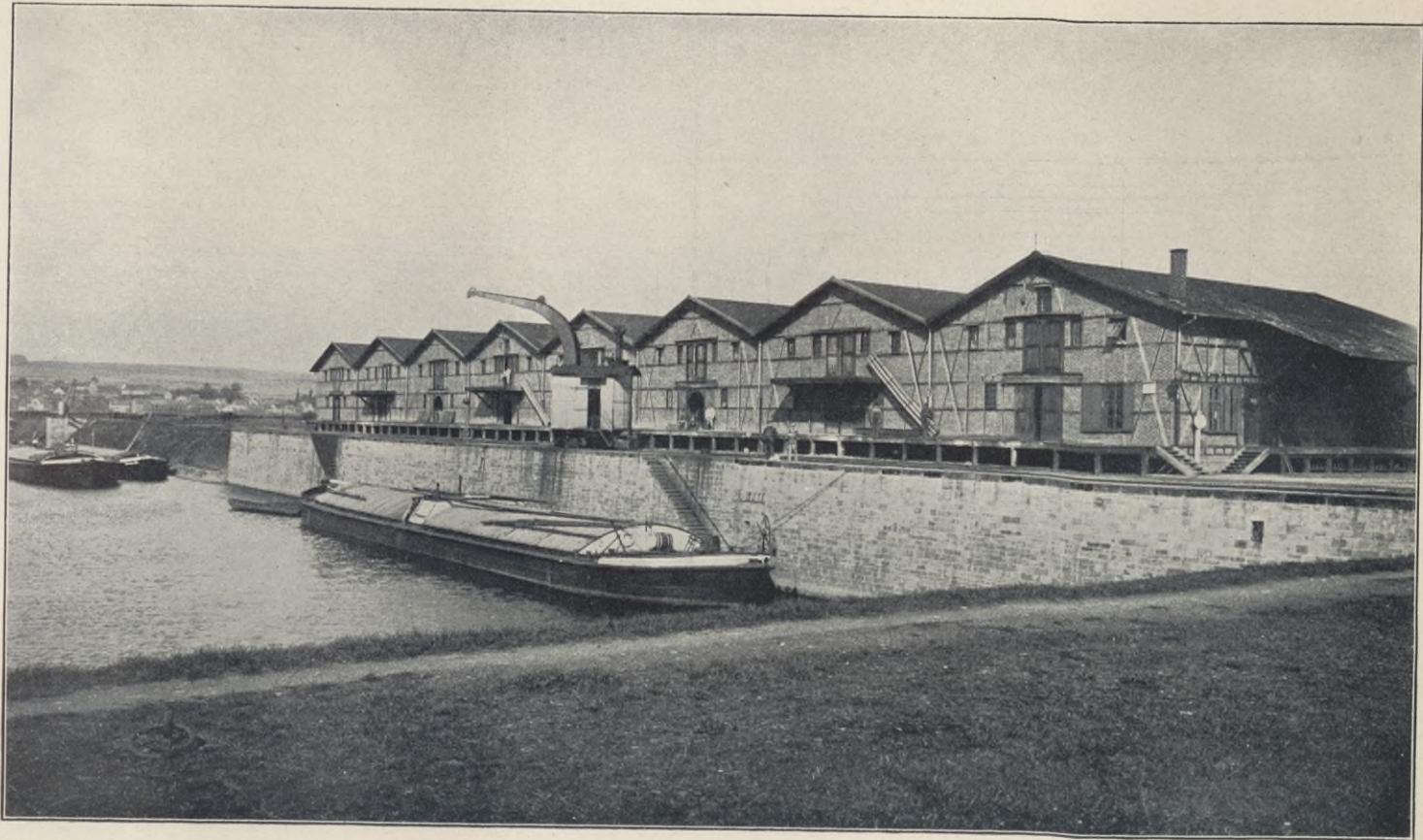
Fuldahafen bei Cassel mit städtischer Lagerhalle.
