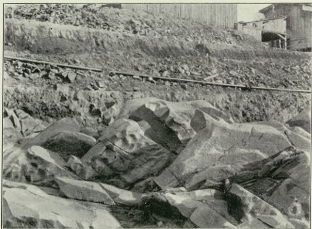
Baugrube, Felsschichten mit Wellenfurchen.
