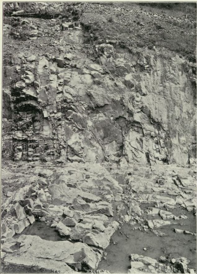
Baugrube der Sperrmauer, Linker Talhang mit Verwerfungen,
