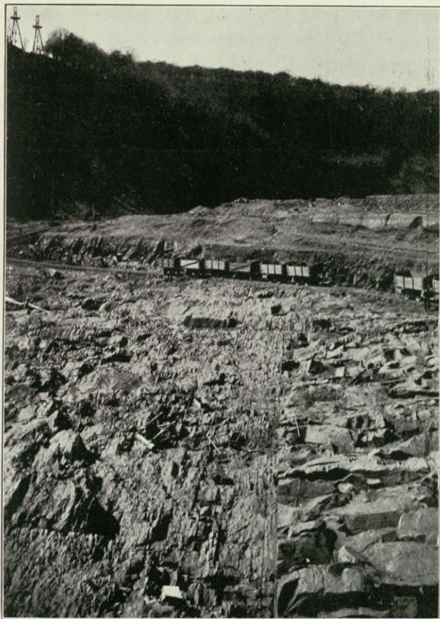
Baugrube. Grenze zwischen Grauwacke und Tonschiefer. 22. 4. 1911.
