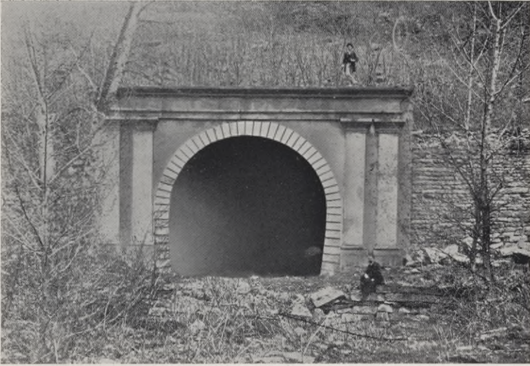
TUNNEL DER TRAGEBAHN, WESTLICHE SEITE
