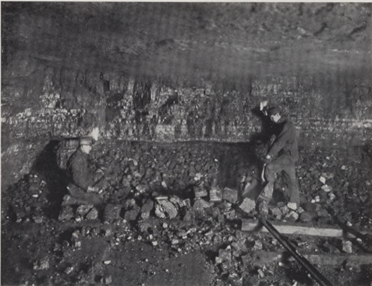
BERGARBEITER BEI DER ARBEIT IN EINEM BERGWERK FUER BITUMINOESE KOHLE DER PITTSBURGH-BUFFALO COMPANY. DIES ZEIGT DIE ARBEITSVERHAELTNISSE "AM PLATZ." DIESE ABBAUSTRECKE IST GERADE GESPRENGT WORDEN, UND DIE MAENNER SIND DABEI DIE KOHLEN IN DIE "HUNDE" ZU LADEN
