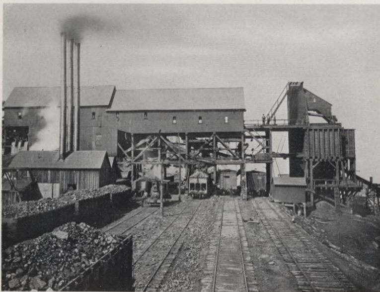
SORTIEREN UND VERLADEN VON BITUMINOESER KOHLE. WESTLICHES PENNSYLVANIEN
