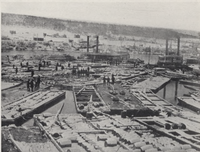
DIE FRUEHERE VERSCHIFFUNG VON PETROLEUM IN DEN OELFELDERN PENNSYLVANIENS. IN FLACHEN BOOTEN TRIEB ES DIE KLEINEREN FLUESSE HINUNTER, UM IN OIL CITY FUER DIE LIEFERUNG NACH PITTSBURGH UND ANDEREN STAEDTEN AM OHIO AUF RADDAMPFER VERLADEN ZU WERDEN. JETZT WIRD DAS OEL DURCH UNTERIRDISCHE ROEHRN BIS AN DAS MEER GEPUMPT
