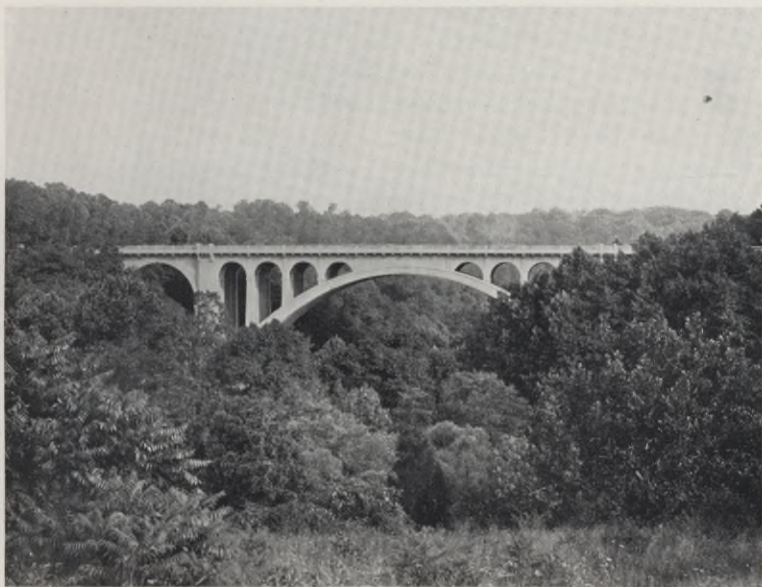
CEMENT BRUECKE UEBER DAS TAL DES WISSAHICKON BEI WALNUT LANE, PHILADELPHIA
