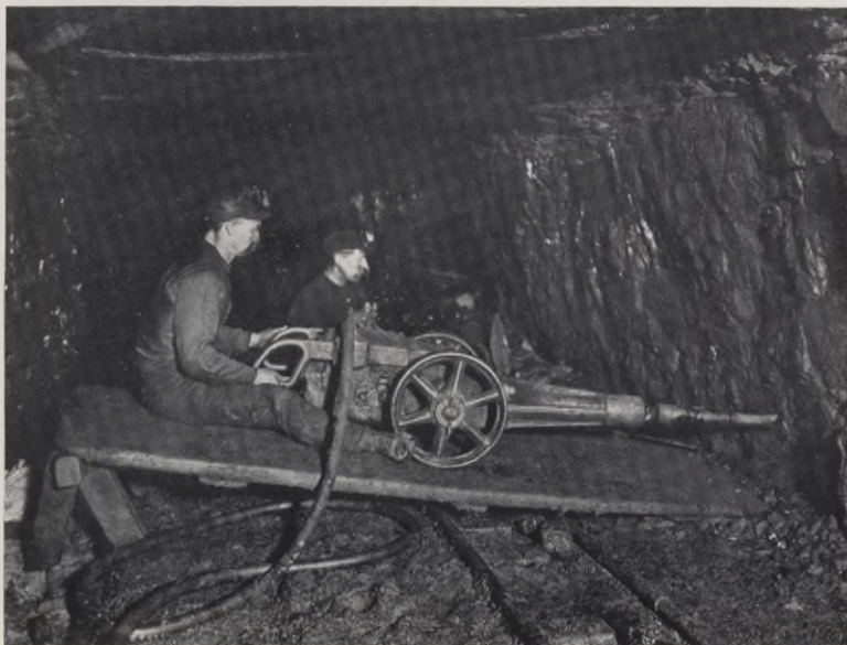
ARBEIT MIT EINER BRECHMASCHINE IN EINER BITUMINOESEN KOHLENGRUBE
