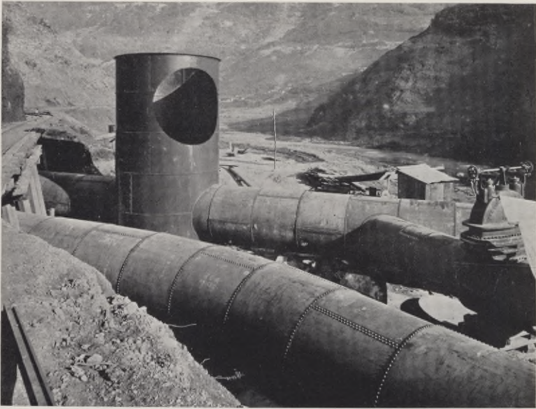
PUMPROHR FUER EINE HYDRO-ELECTRISCHE ANLAGE IN MEXICO. ERBAUT VON DER RITER-CONLEY MANUFACTURING COMPANY, PITTSBURGH
