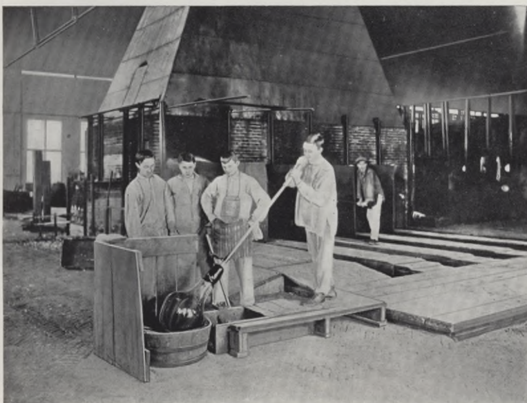
DAS BEHANDELN VON GESCHMOLZENEM GLAS, UM EINEN FENSTERGLASSCYLINDER ZU BLASEN
