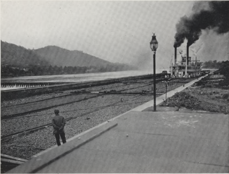
KOHLENSCHLEPPER IN SCHLEUSE NO. 2, OHIO
