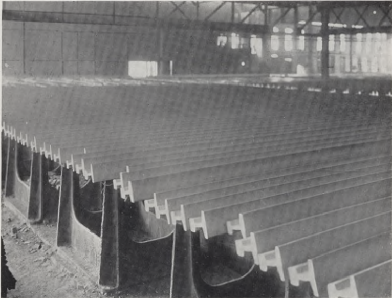
HEISSE SCHIENEN AUF DEN KUEHLRAHMEN
