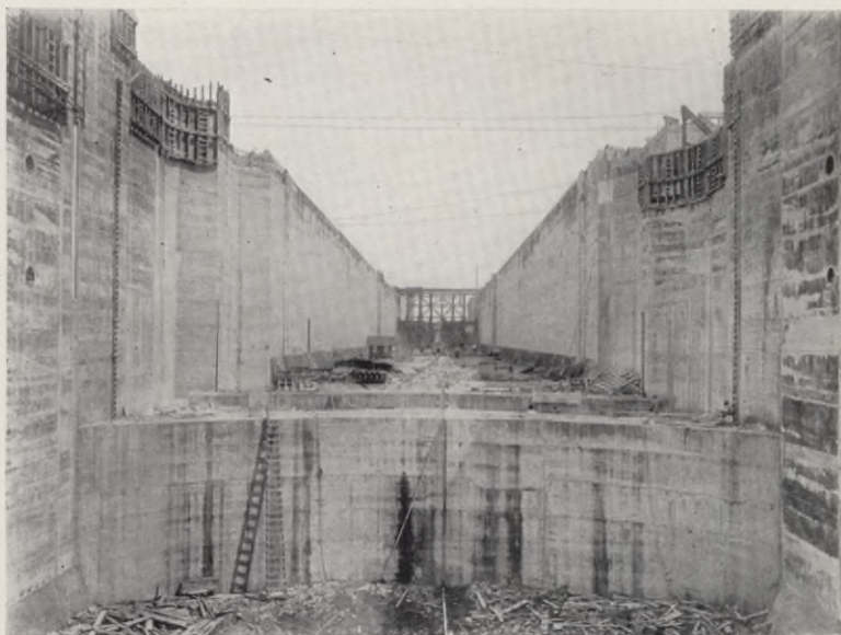
DIE OBERE GATUN SCHLEUSE IM PANAMA KANAL AUS PENNSYLVANIA CEMENT ERRICHTET
