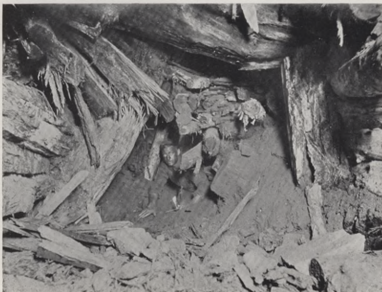
EINGEBROCHENE STUETZEN IN EINEM KOHLENBERGWERK
