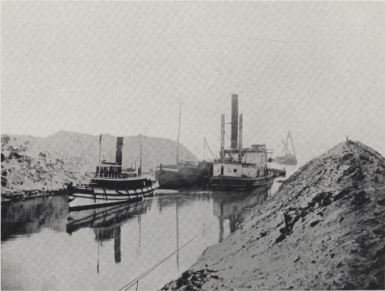
BAGGERARBEITEN IM CAPE COD KANAL
