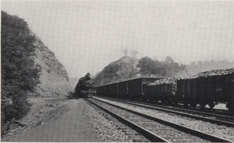
KOHLENZUG DER PENNSYLVANIA EISENBAHN. DIE ALTEN HOLZWAGGONS FASSEN 25 TONNEN, DIE NEUEN STAEBLERNEN 50 TONNEN
