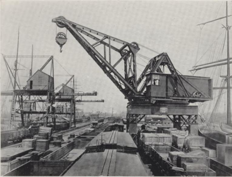
EXPORT PIER G, PORT RICHMOND, PHILADELPHIA, DER PHILADELPHIA UND READING EISENBAHN
