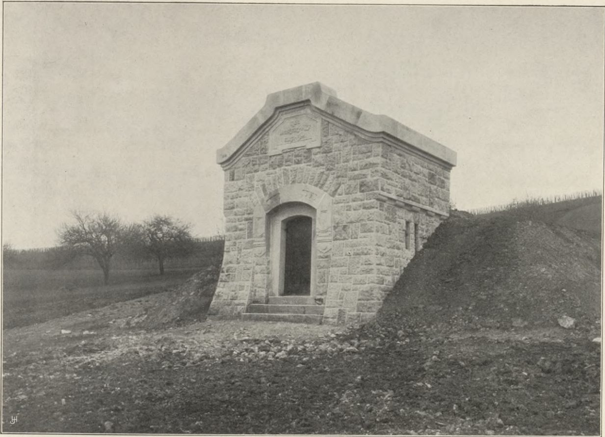
Fig. 12. Ortshochbehälter für Sulzheim.
