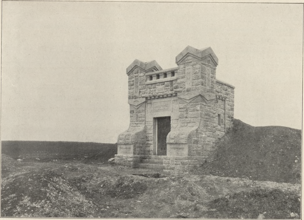
Fig. 10. Ortshochbehälter für Wörrstadt.
