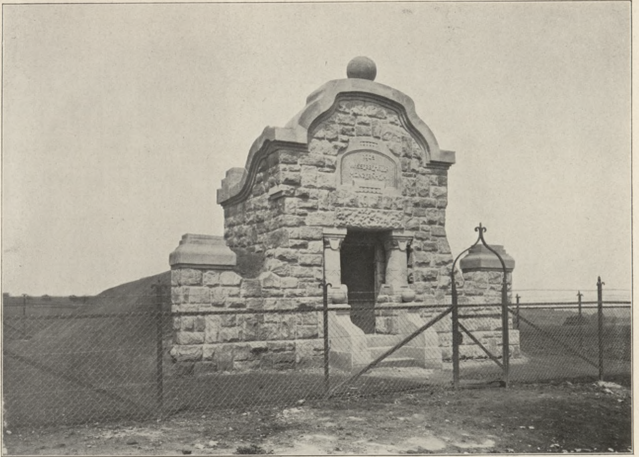
Fig. 12. Ortshochbehälter Monzernheim. (In gleicher Ausführung für Bermersheim.)
