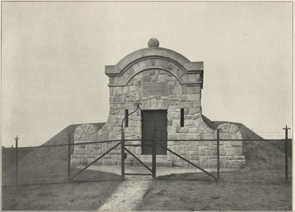
Fig. 10. Ortshochbehälter Abenheim. (In gleicher Ausführung für Pfeddersheim.)
