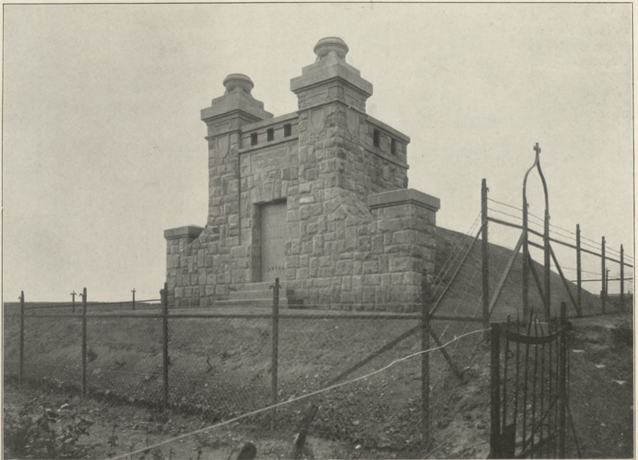
Fig. 11. Ortshochbehälter Westhofen. (In gleicher Ausführung für Mettenheim.)
