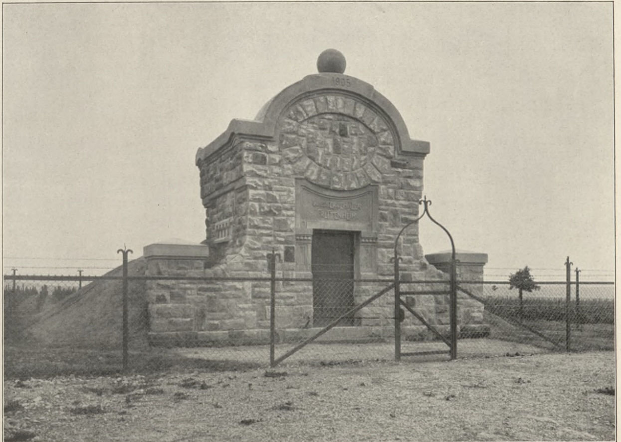
Fig. 13. Ortshochbehälter Frettenham. (In gleicher Ausführung für Gundheim.)
