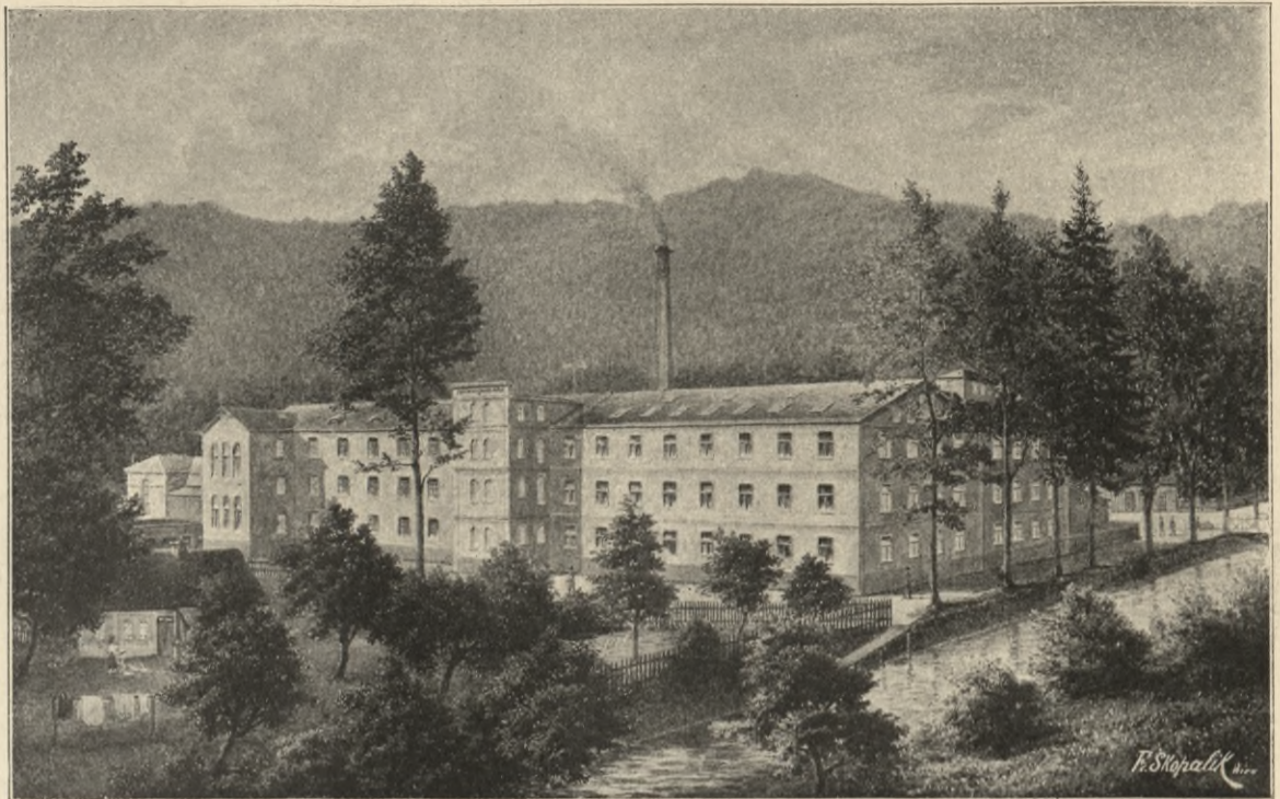
Fabrik in Raspenau.
