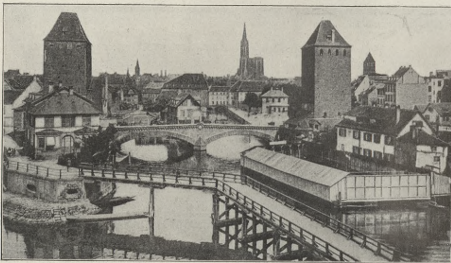
Les ponts couverts.
