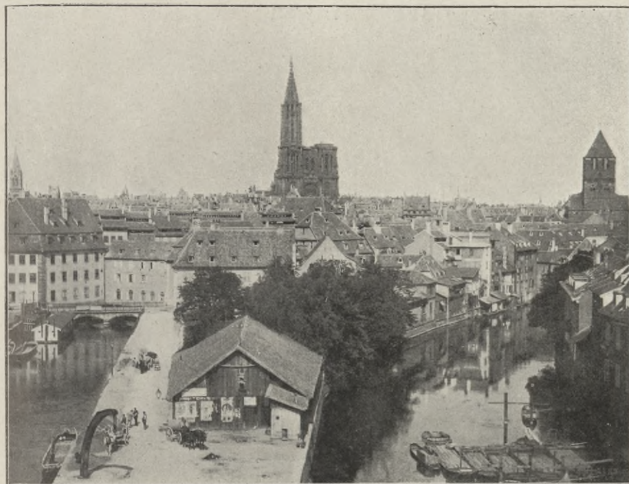
Maisons du quartier des Moulins.
