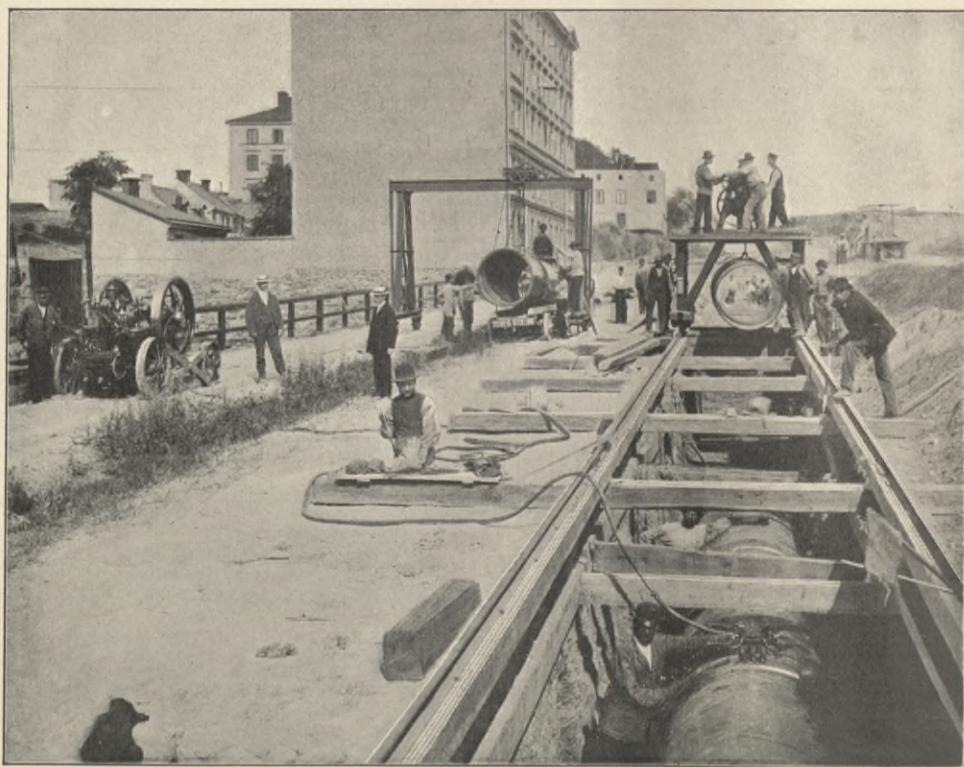
Fig. 64. Läggnig af 122 cm:s ledning i Hornsgatan.
