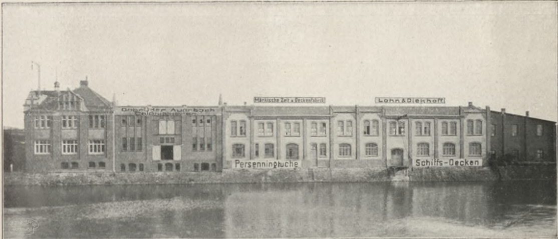
Lagerhäuser Gebr. Auerbach und Lohn & Diekhoff.
