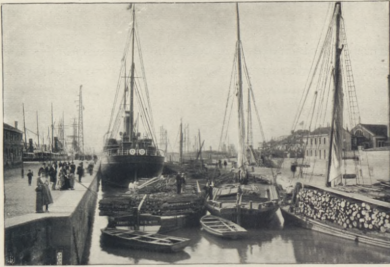
Écluses du bassin à flot.
