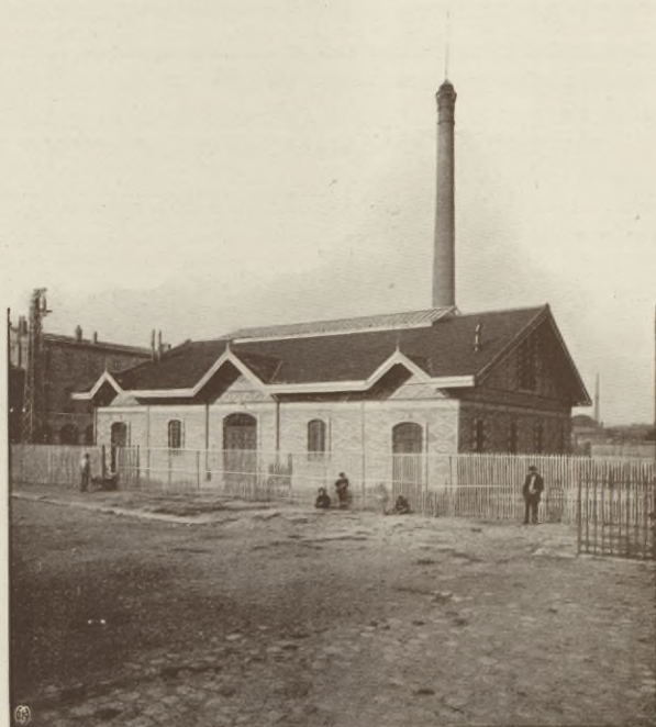
Machinerie de la Chambre de commerce.
