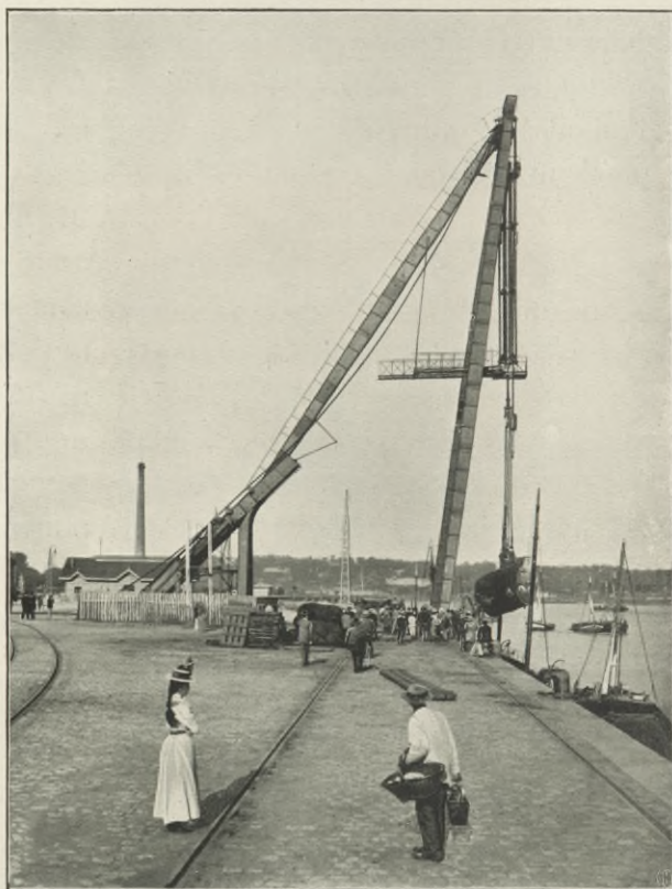
Bigue de 80 tonnes.
