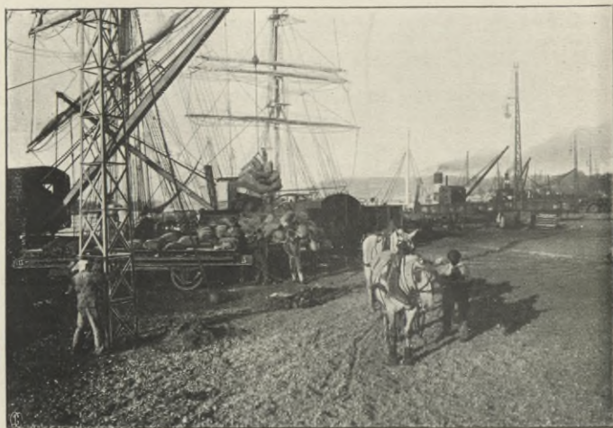
Appontements de Queyries vus de terre.
