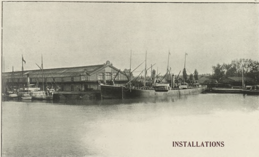
Bassin à flot.
