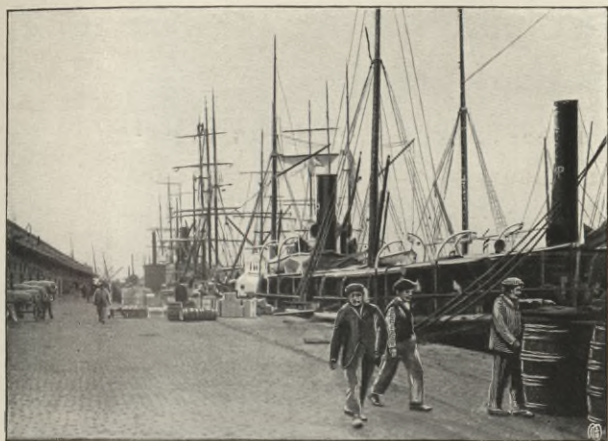
Quai de la Halle métallique.
