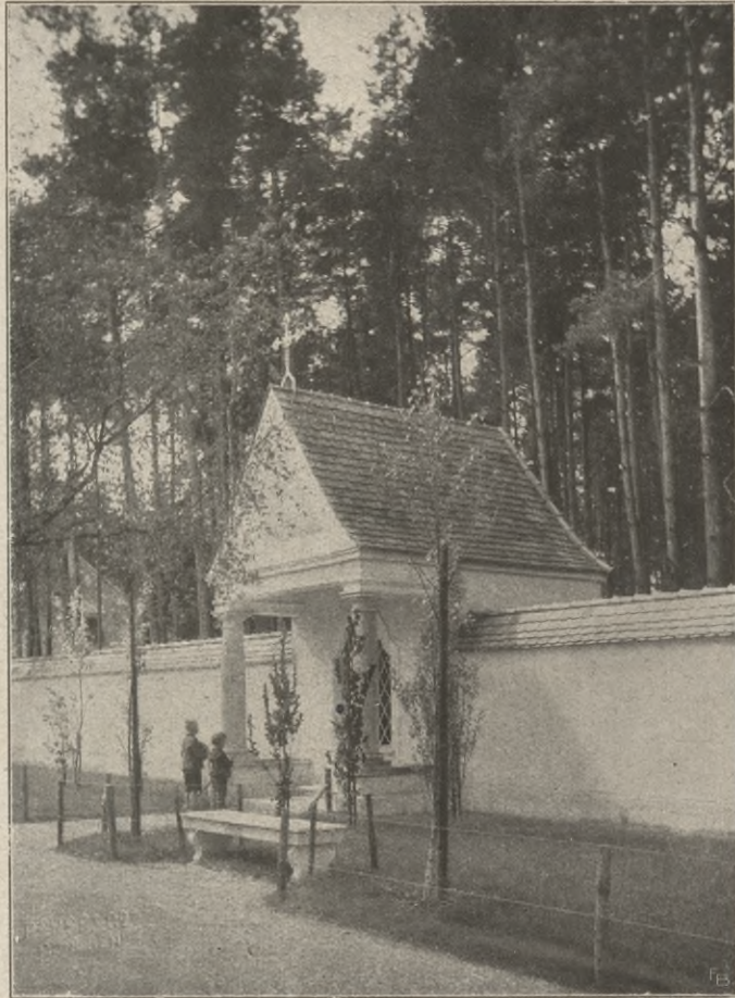
Wegkapelle in der Friedhofsmauer
