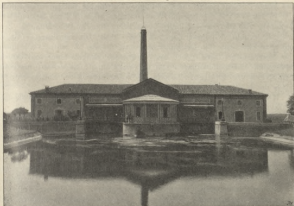
Fig. 508. Pumpwerk bei Marozzo, Valle Gallare.
