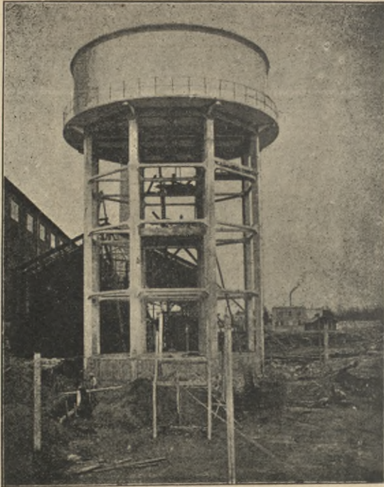
Fig. 16. — Wasserreservoir von Billancourt.
