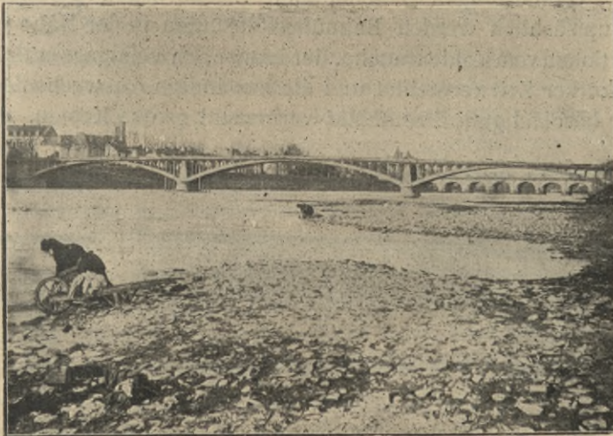
Fig. 24. — Gesamtbild der Chatellerault-Brücke.
