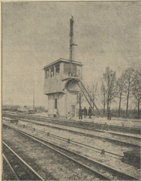
Fig. 8. — Ansicht eines Geleisestellhäuschens zu Joinville bei Paris.
