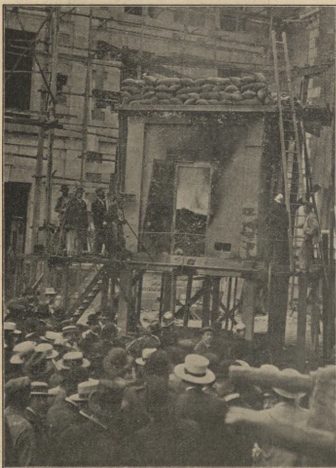
Fig. 5.— Ansicht des kleinen Eisenbeton-Gebäudes, welches im August 1900 mehreren Brandproben unterworfen wurde.
