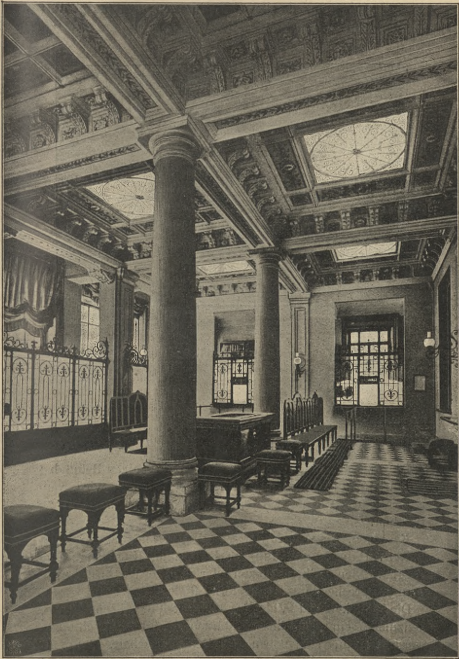
Fig. 29. — Hennebique-Säule und Plafond mit reicher architectonischer Verzierung ausgeführt in Turin.
