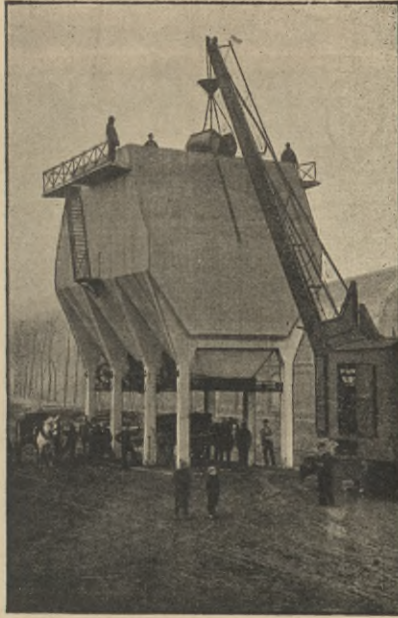
Fig. 4. — Ansicht der Kohlenbehälter (Silos) zu Lens in Frankreich.
