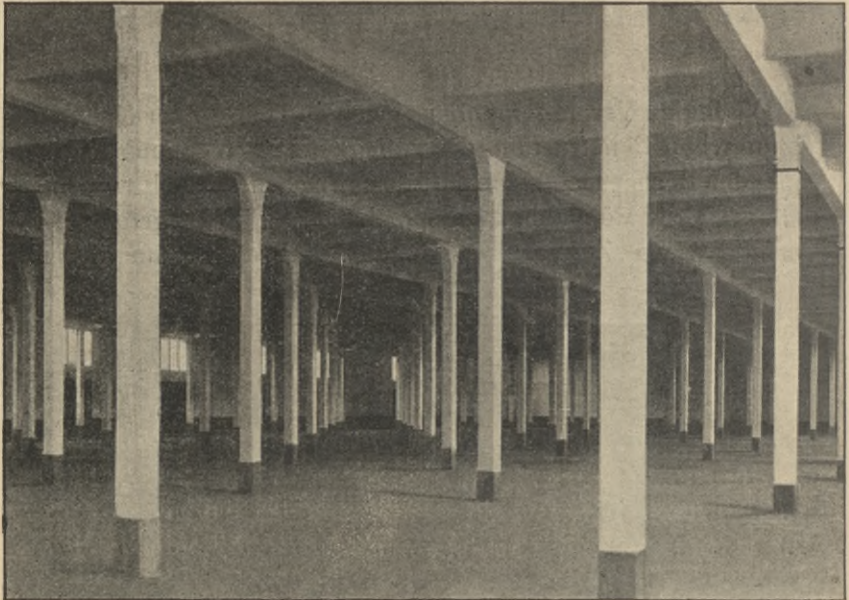
Fig. 12. — Innenansicht der grossen Zuckerdocks zu Calais. — Höhe der Säulen 6 m. Spannweite zwischen den Säulen 9 m. Das auf den Säulen ruhende Terrassendach ist mit 35 cm Erde überdeckt.
