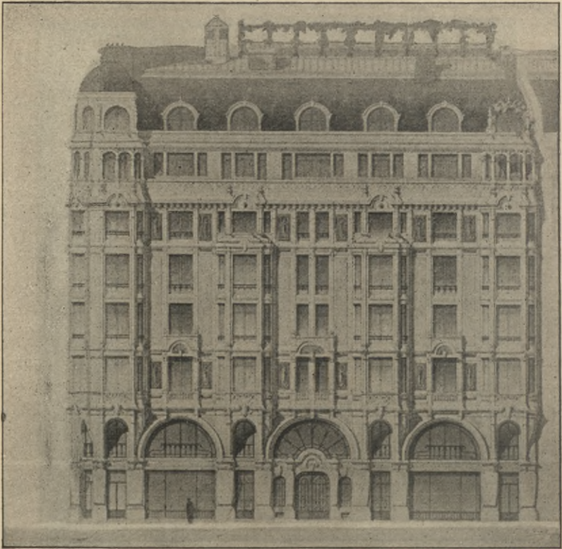
Fig. 10. — Ansicht des Hennebiqueschen Wohn- und Geschäftshauses in Paris. Höhe 28 m. Stärke der Tragwände im Erdgeschoss 18 cm.
