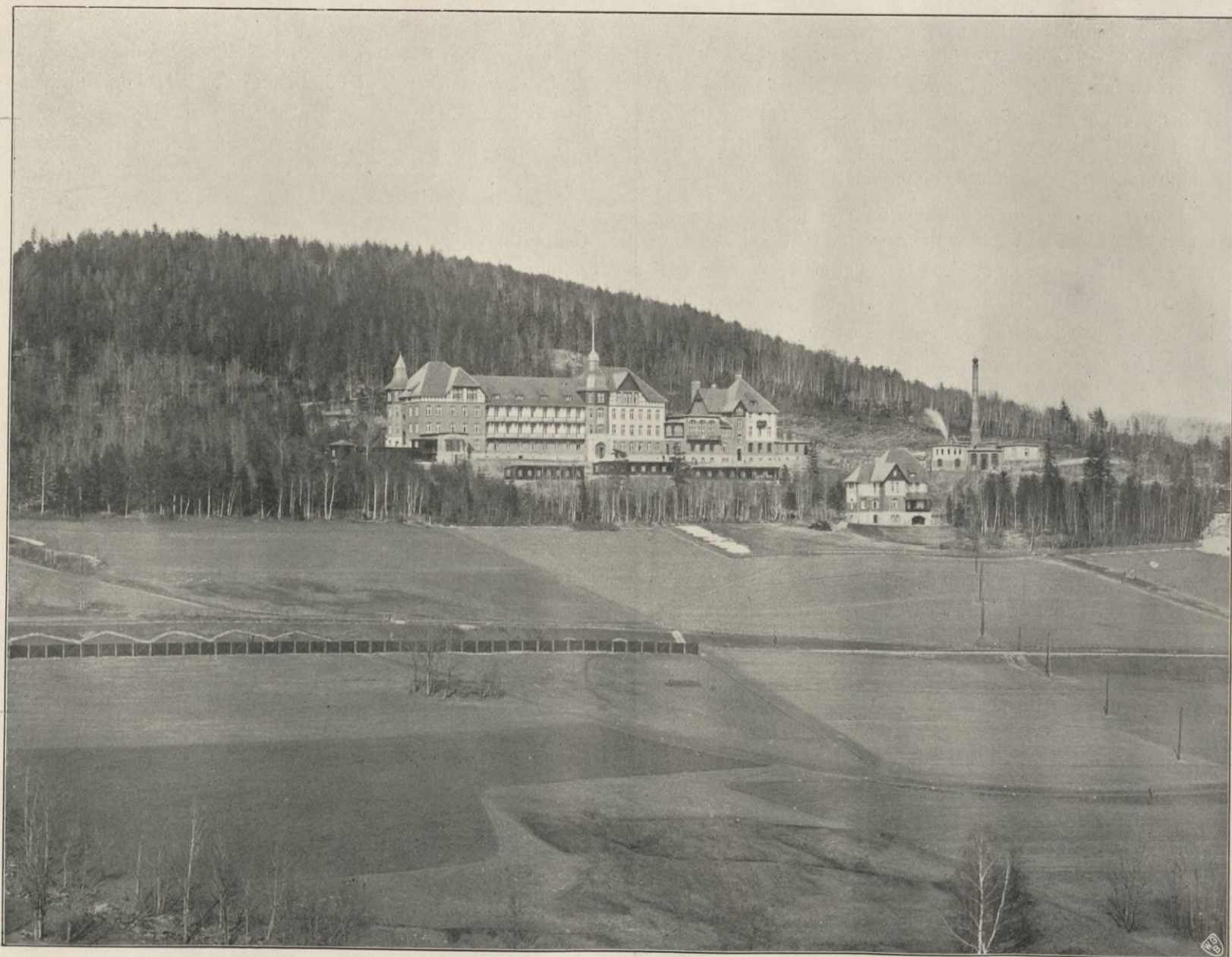
Heilstätte Moltkefels. — Gesamtansicht.
