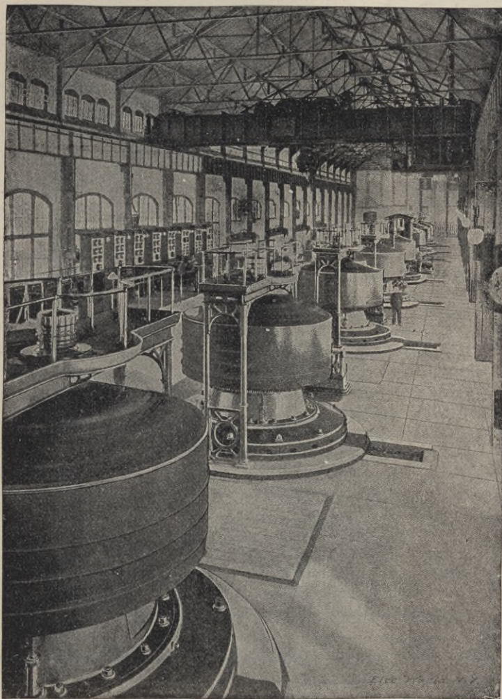
Fig. 148. Ansicht der Niagara Kraftstation.
