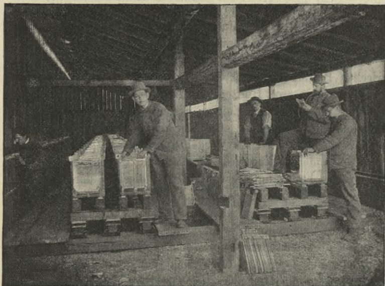
Aufstellung einer Pufferbatterie.
