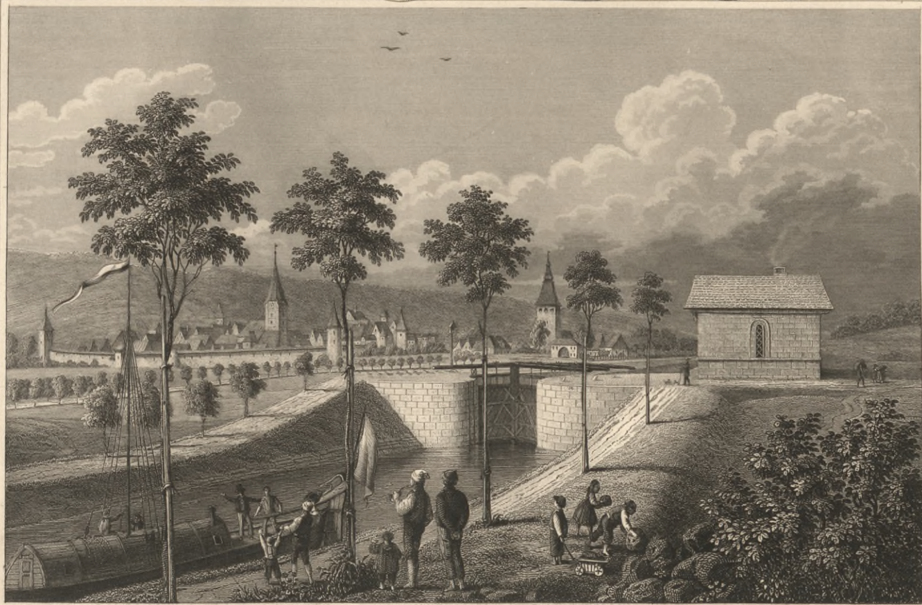
Die Schleuse mit dem Schleusenwärterhaus bei Berching.
