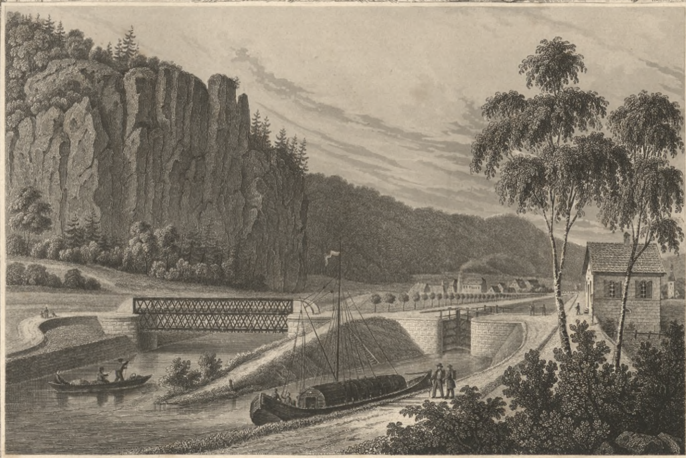
Die Schleuse nebst Gatterbrücke bei Schelleneck.
