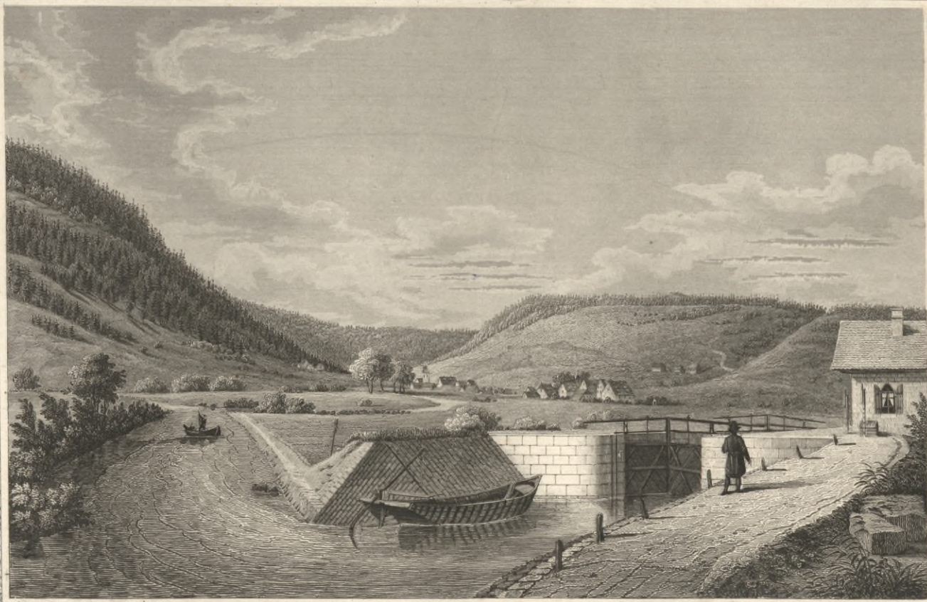
EINMÜNDUNG des Kanals in die Altmühl bei Dietfurt.
