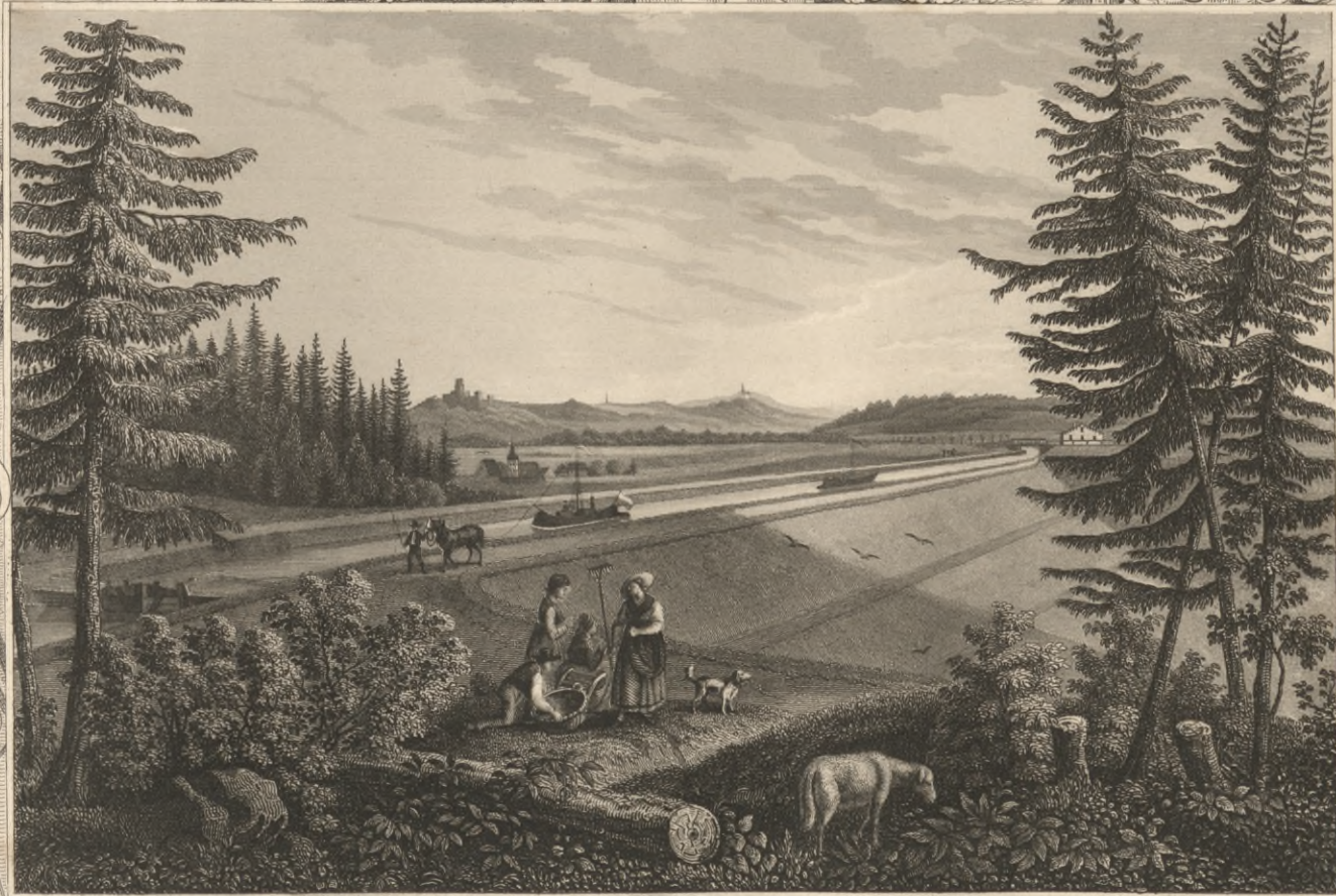
Der Grubenbacher = Damm bei Neumarkt.
