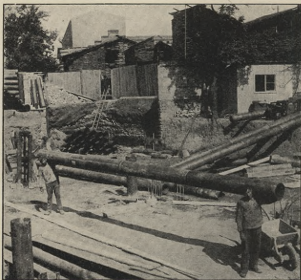
Fig. 10. Transport der 10 m langen Mast-Pfähle zur Ramme.
