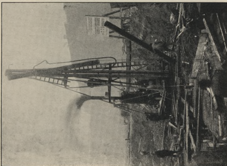
Fig. 11. Einsetzen der Holzjungfer in die Pfahlform.
