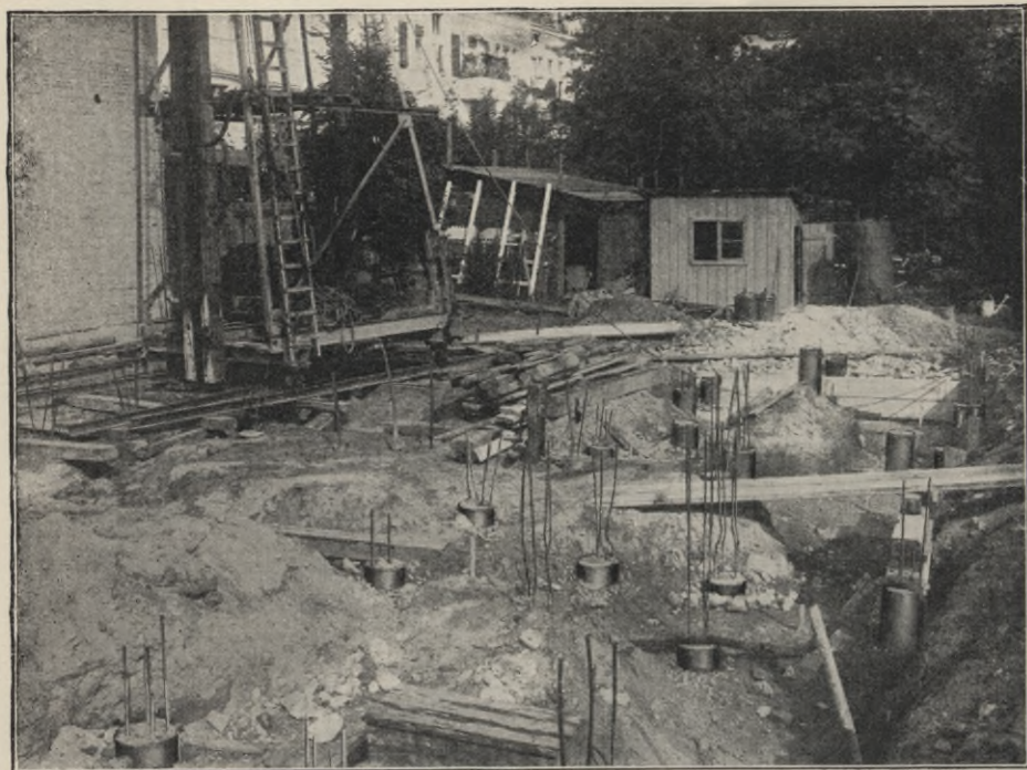
Fig. 31. Baustelle während der Rammarbeiten.
