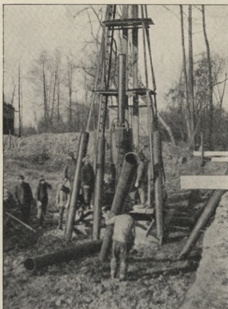
Fig. 24. Konische Betonpfähle „Mast“.
