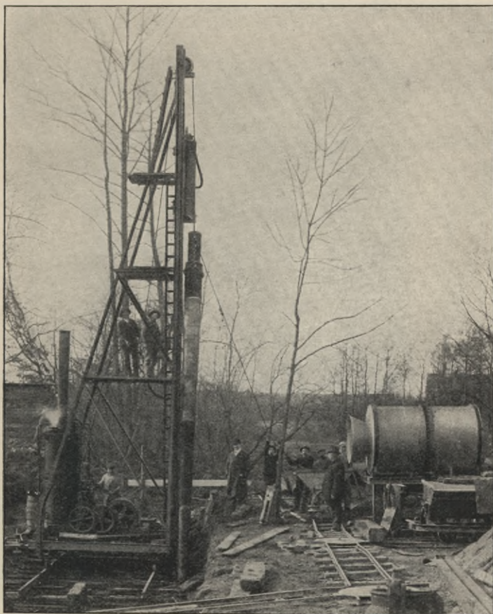
Fig. 23. Konische Betonpfähle „Mast“.
