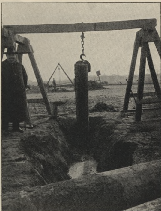
Fig. 15. Gegen Moorsäure isolierter Betonpfahl „Mast“ am Osthafen zu Berlin.
