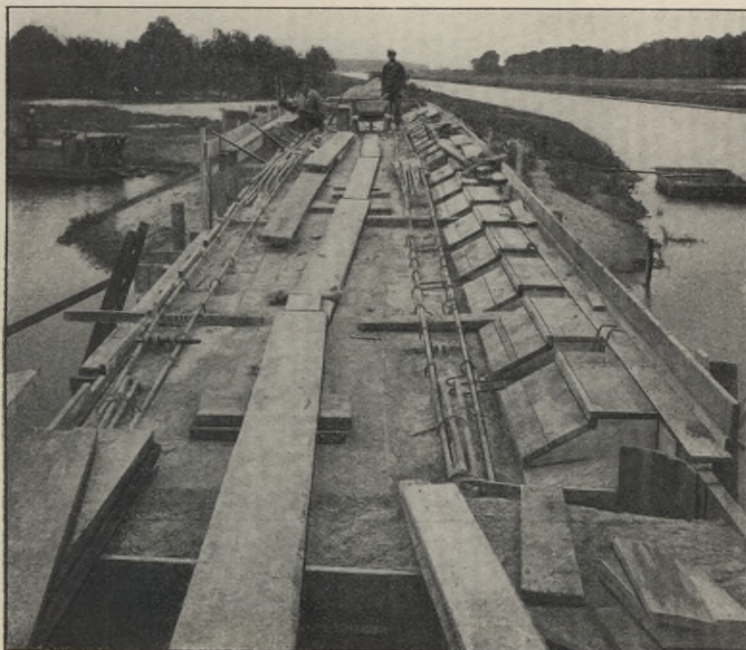
Fig. 66. Havelbrücke während der Ausführung.
