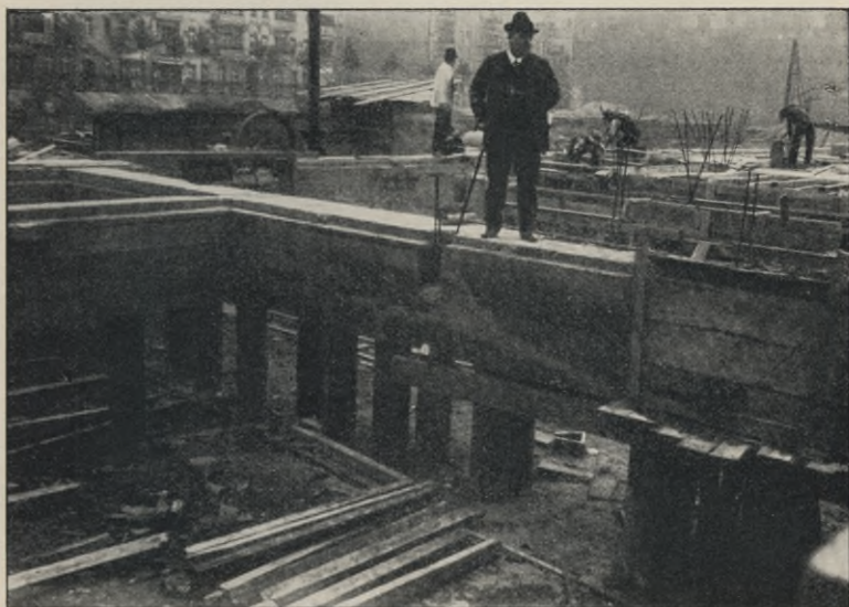
Fig. 44. Eisenbetonbalken und -decken auf Betonpfählen „Mast“ beim Kirchenbau Berlin-Neukölln.
