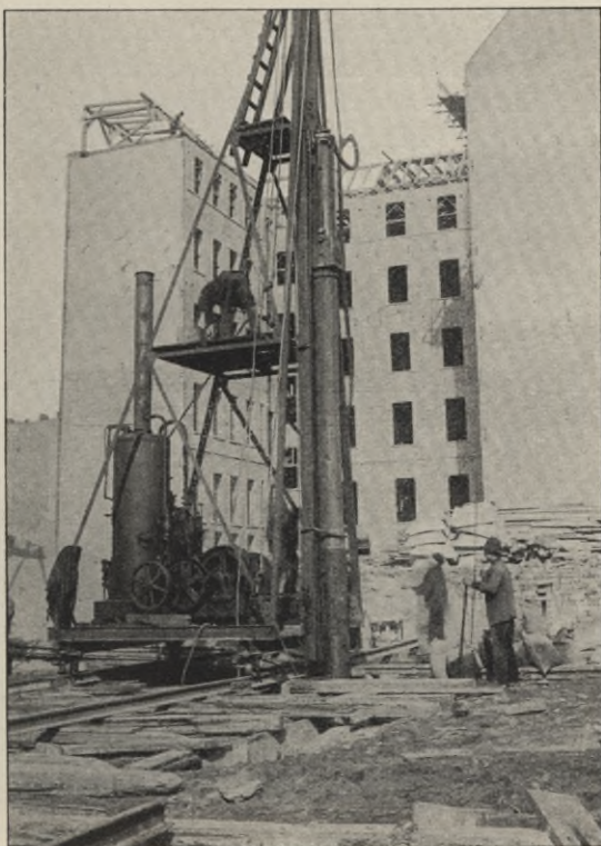
Fig. 17. Einrammen von Betonpfählen „Mast“ neben Neubauten.
