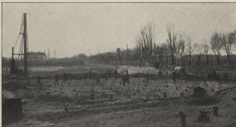
Fig. 69. Baustelle während der Rammarbeiten.
