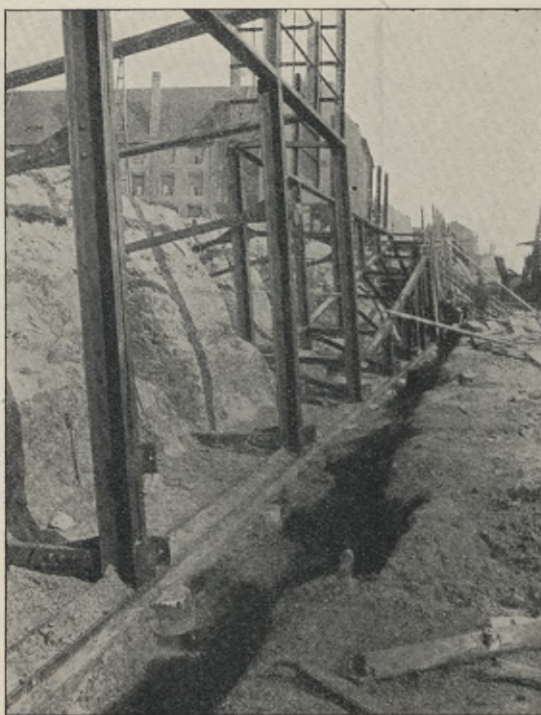
Fig. 51. Bollwerk auf Betonpfählen „Mast“ am Stralauerplatz zu Berlin.
