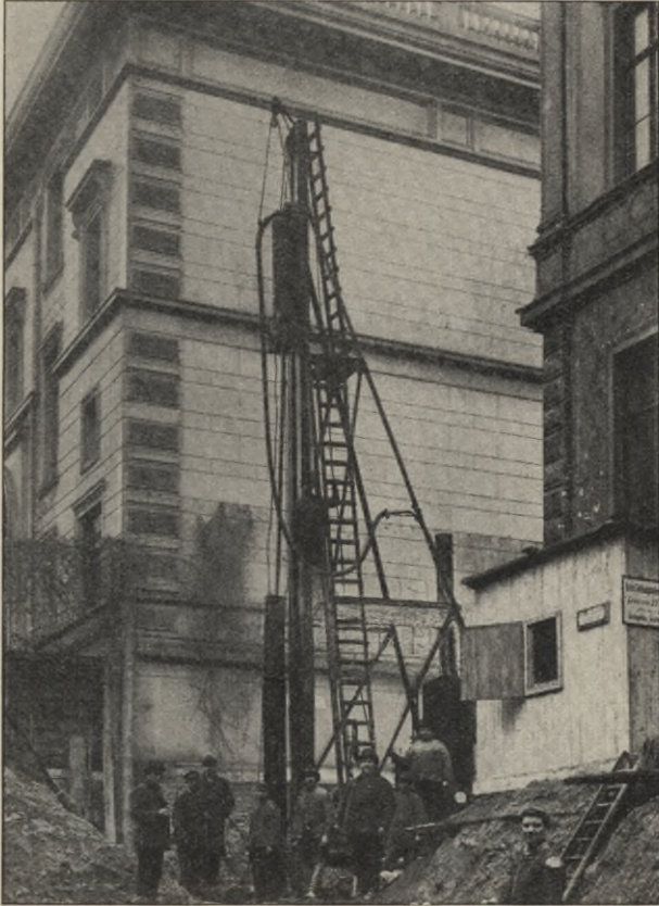
Fig. 19. Blick von der Straße auf die Baustelle.
