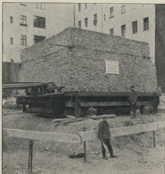
Fig. 48. Gemeindeschule Zechlinerstraße. Belastung der Betonpfähle „Mast“ mit 284 000 kg.
