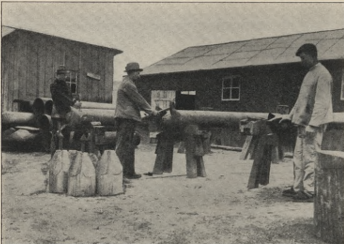
Fig. 8. Einsetzen der Holzklötze.
