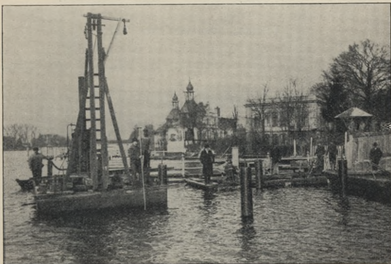
Fig. 50. Betonpfähle „System Mast“ für ein Bootshaus an der Oberspree,
