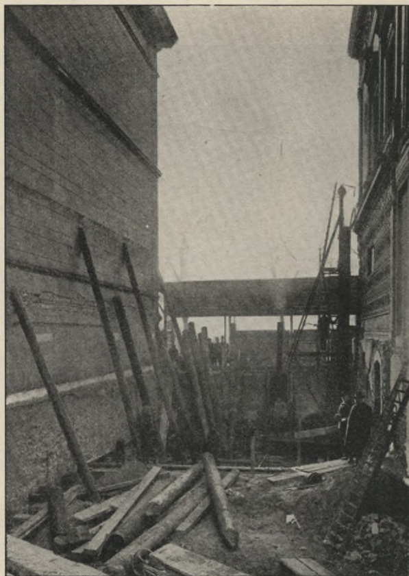
Fig. 20. Blick vom Hofe auf die Baustelle.
