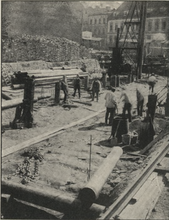
Fig. 13. Betonieren der Pfähle auf der Baustelle.
