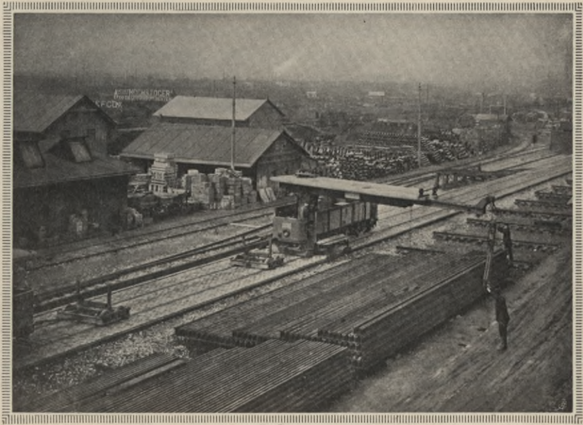
Verladen von Straßenbahnschienen am Nordbahnhof
