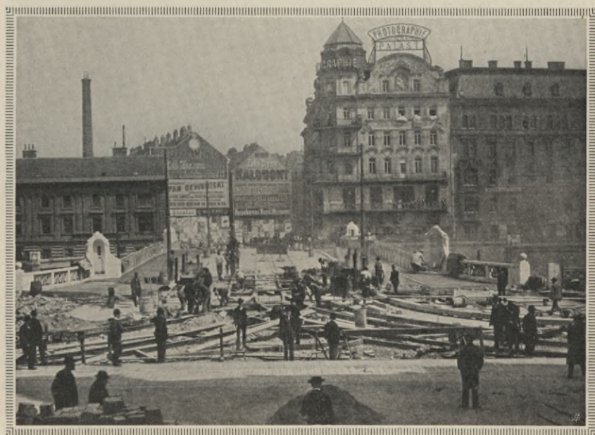
Einbau der Gleisverbindungen auf der Marienbrücke
