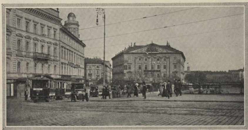
Praterstraße bei der Ferdinandsbrücke
