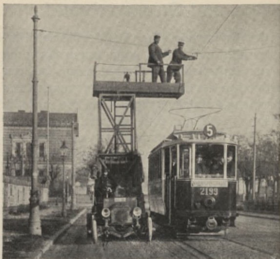
Untersuchung der Oberleitung während des Betriebes
