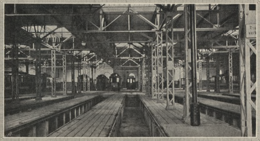
Wagenhalle mit eisernem Tragwerk für die Betondecke im Bahnhof Brigittenau
