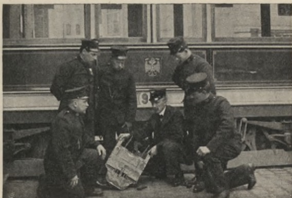
Erklärung des Unterleitungs-Stromabnehmers
