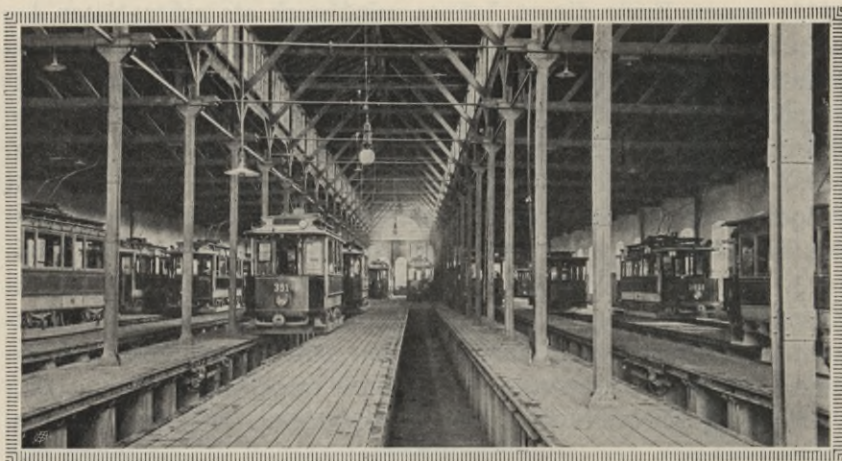
Wagenhalle mit Dachstuhl aus Holz im Bahnhof Rudolfsheim
