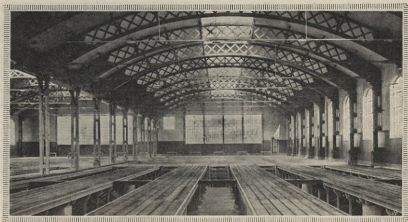
Halle im Bahnhof Kagran, moderne Holzkonstruktion
