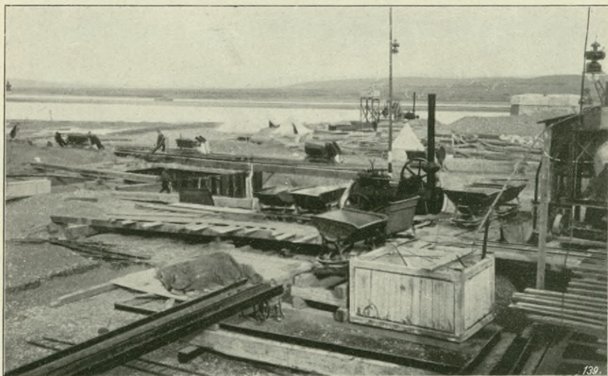
Gründung der Brückenpfeiler für die Euphratbrücke im Zuge der Bagdadbahn.
