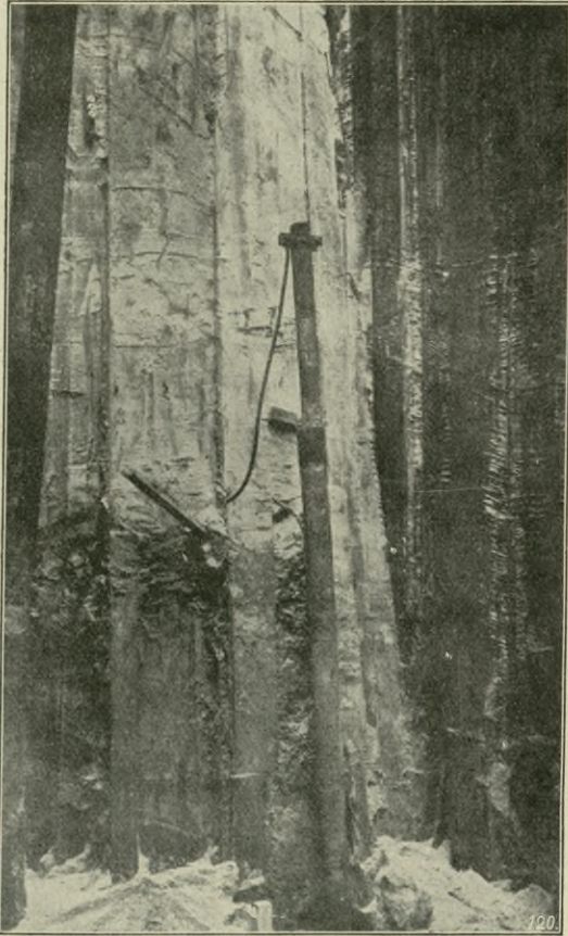
Larsseneisen beim Bau des Spreetunnels in Berlin.
