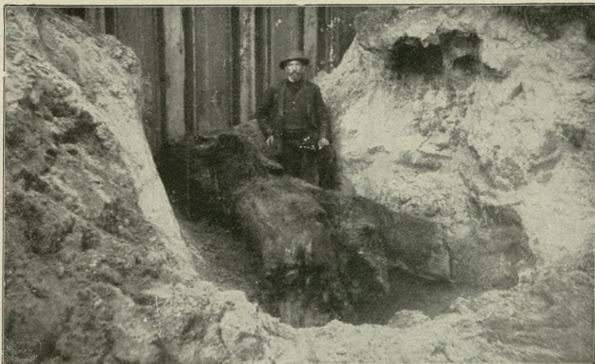
Durchrammen eines Baumstammes mittels Larsseneisens beim Bau des Hafens für die Zeche Viktoria Mathias, Altenessen.
