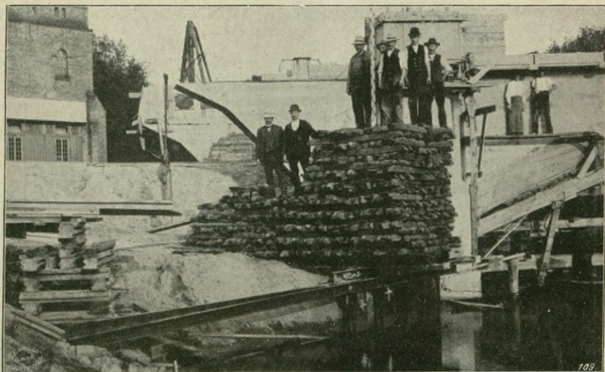
Belastungsversuch mit Larsseisen in lotrechter Richtung (Fürstenwalde). (Vergl. Zentralblatt der Bauverwaltung Nr. 102, Jahrg. 1913, Artikel von Reg.-Baumeister Privatdozent Karl Bernhard.) Es wird festgestellt, daß die Wände Profil II bzw. III (20) eine lotrechte Last von 48,75 t auf 1,0 m Wand bei einer bleibenden Einsenkung von 11,5 mm bzw. 6,5 mm ohne weiteres Nachgeben aushalten und daß die erprobten Rammformeln auch für Larsseisen zur Ermittlung der Tragfähigkeit Anwendung finden können.
