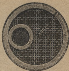
Abb. 2. Comper-Winderhitzer (Horizontalquerschnitt).
