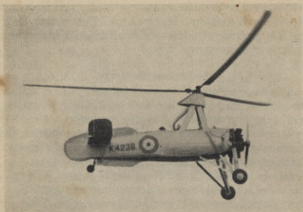
Abb. 5. Der bei der englischen Luftwaffe als Verbindungsflugzeug eingeführte Tragschrauber (Autogiro) de la Cierva „Rota“.
