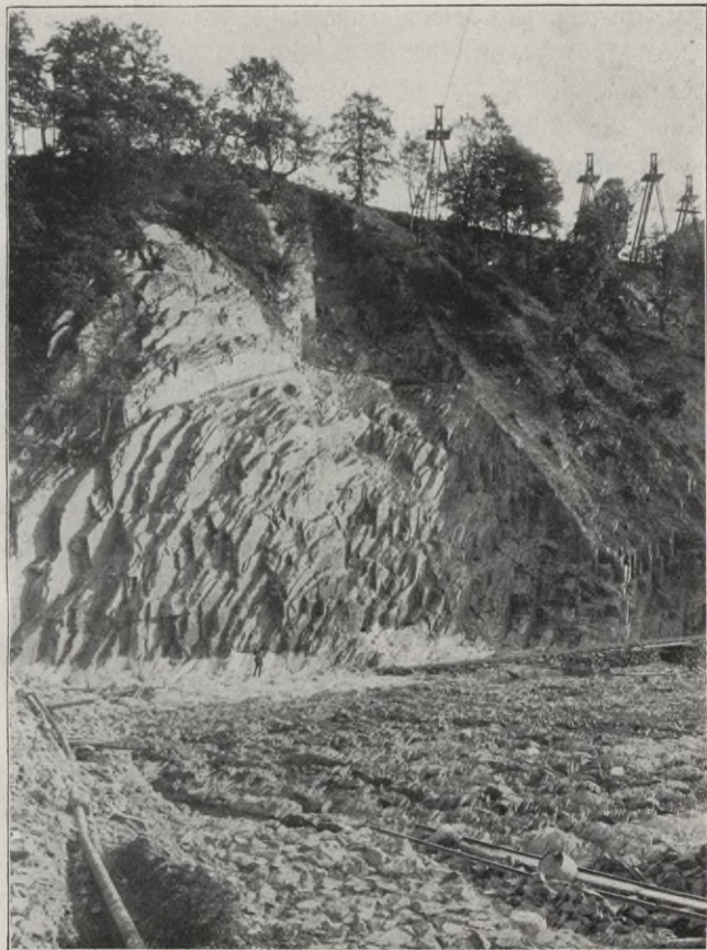
Baugrube, Blick nach dem rechten Talhang.
