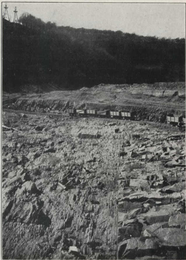
Baugrube. Grenze zwischen Grauwacke und Tonshiefer. 22. 4. 1911.
