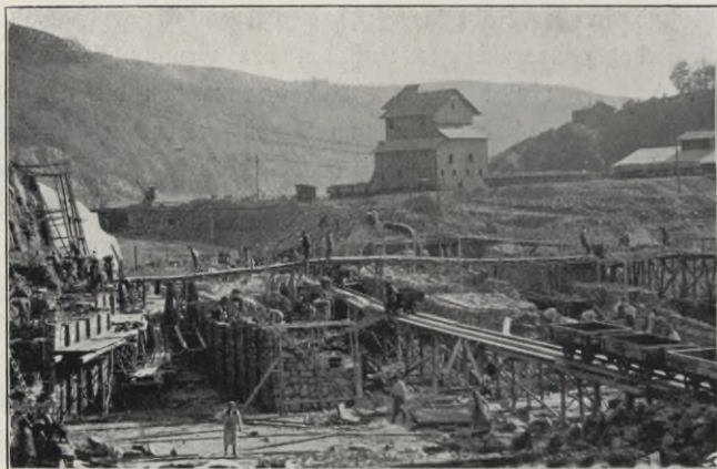
Baugrube für die Durchlässe am linken Talhang.
