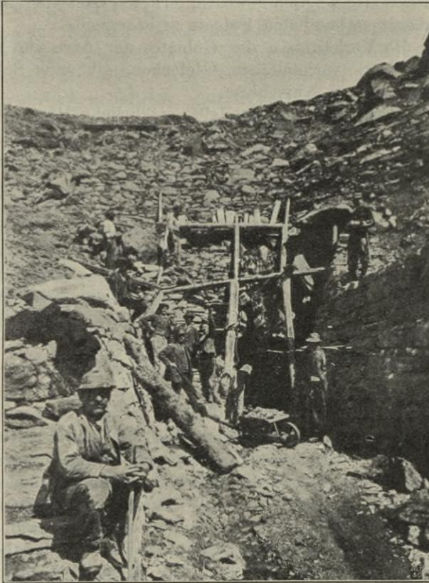
Abbildung Nr. 17. Unterirdische Galerie zum Gletscher von „Tête Rousse“.
