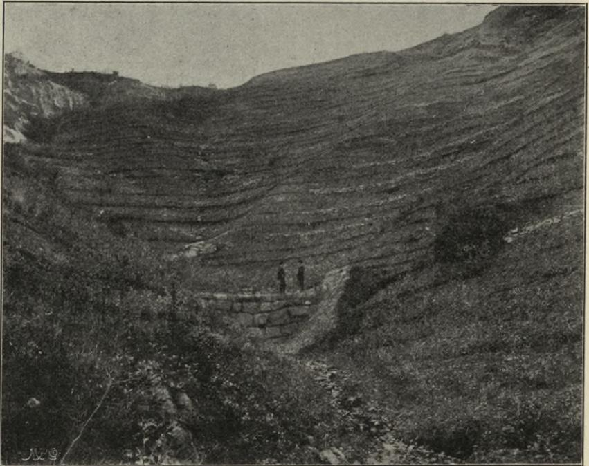
Abbildung Nr. 59. Böschungsversicherung mittels Verflechtung und Trockenmauern, Rivo di Faedo, Südtirol.
