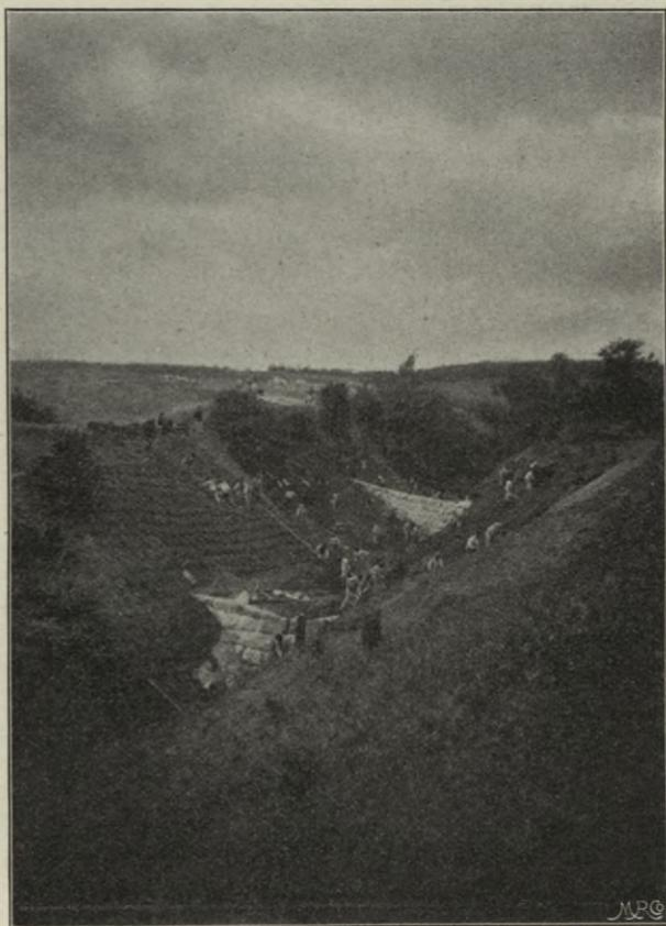
Abbildung Nr. 60. Böschungsversicherung mit Rasenbelag. Sohlenstaffelung mit Steinsperren. Litavkagebiet, Böhmen.
