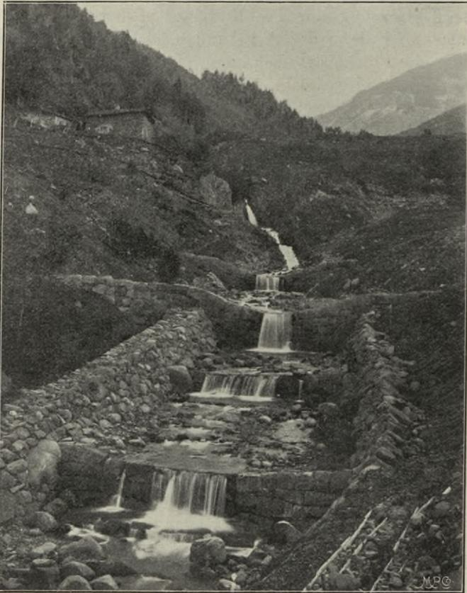
Abbildung Nr. 62. Versicherung gegen Erosion und Corrosion im Rivo Lungo, Südtirol.
