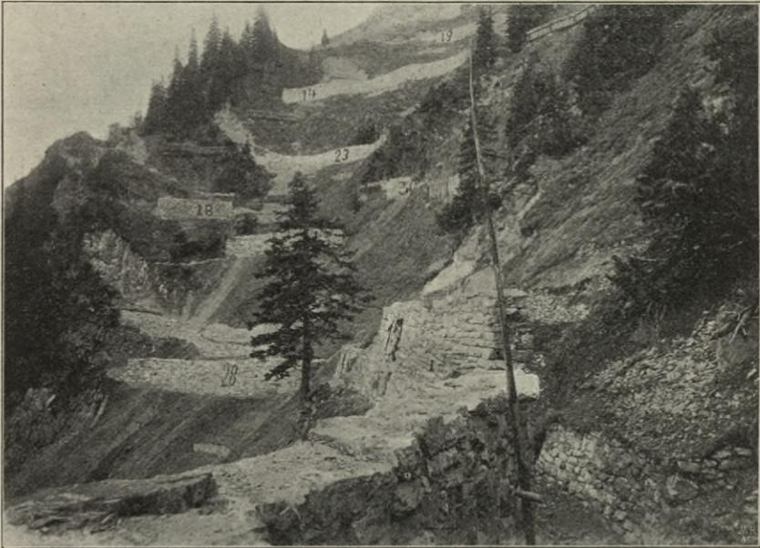
Abbildung Nr. 20. Schneefänge in Trockenmauerung am Arlberge.
