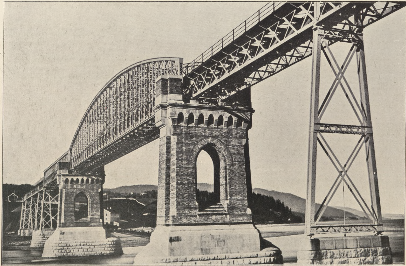
Abb. 56. EISENBAHNBRÜCKE ÜBER DEN MINNESUND IN NORWEGEN ausgeführt 1880 von der GESELL- SCHAFT HARKORT IN DUISBURG am Rhein.
