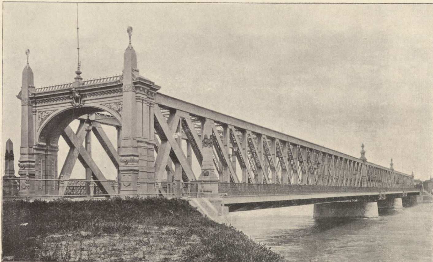
Abb. 51 STRASSENBRÜCKE ÜBER DEN RHEIN BEI KEHL-STRASSBURG, ausgeführt von der GESELLSCHAFT HARKORT IN DUISBURG am Rhein.
