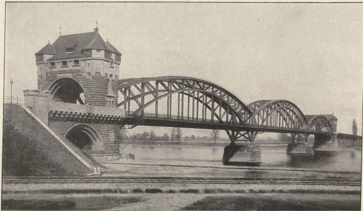
Abb. 52 EISENBAHNBRÜCKE ÜBER DEN RHEIN BEI WORMS. Entworfen und ausgeführt 1898–1900 von der GESELLSCHAFT HARKORT IN DUISBURG am Rhein, Baurat Hofmann in Worms und R. Schneider in Berlin
