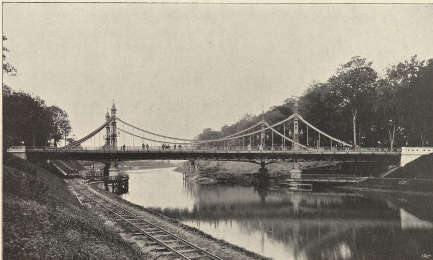
Abb. 55. STRASSENBRÜCKE AM MÜHLENTOR IN LÜBECK ÜBER DEN ELBE-TRAVE-KANAL ausgeführt 1899 von der GESELLSCHAFT HARKORT IN DUISBURG am Rhein.
