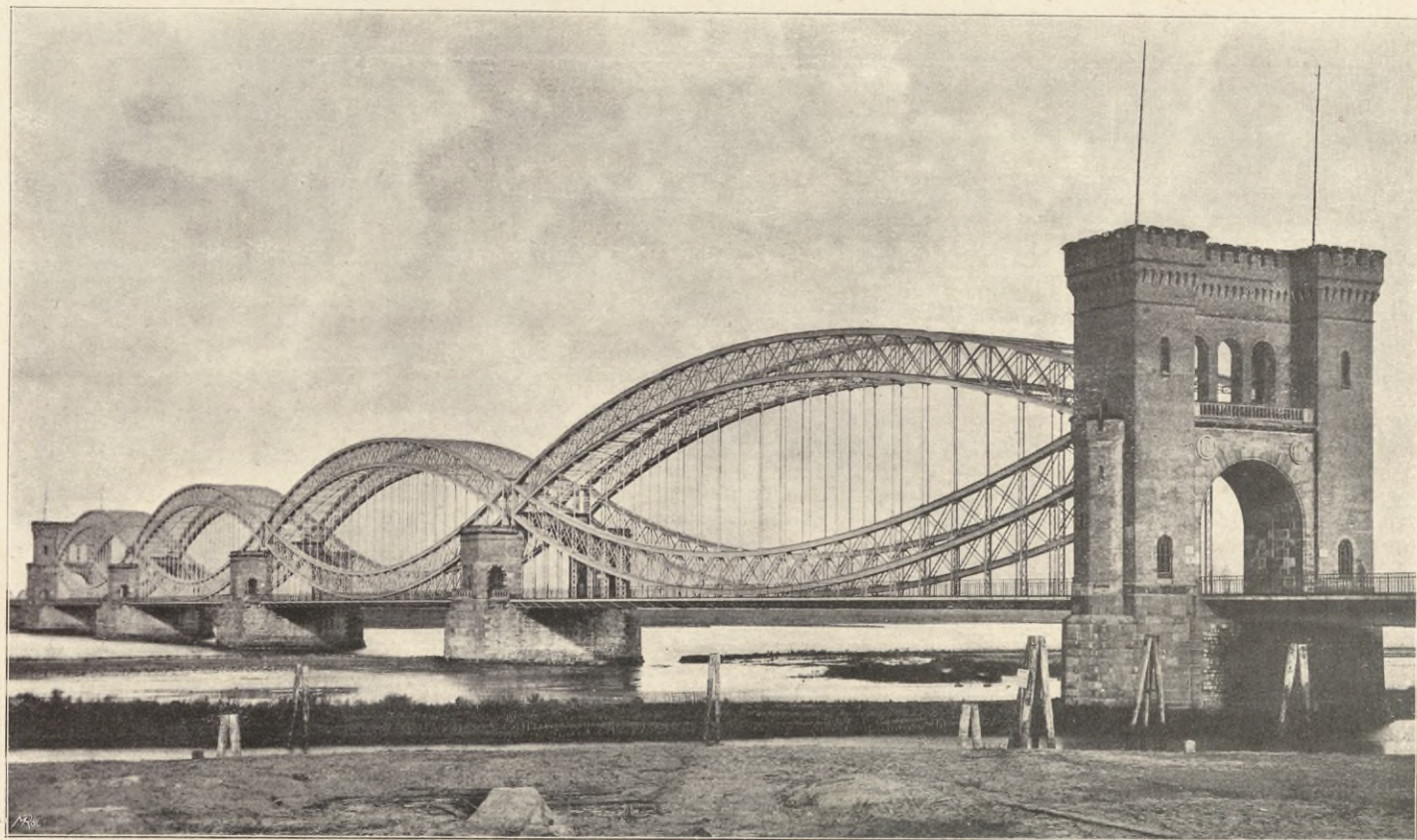
Abb. 49. EISENBAHNBRÜCKE ÜBER DIE SÜDERELBE BEI HARBURG (Venlo-Hamburger Bahn) ausgeführt 1870—1871 von JOH. CASPAR HARKORT IN HARKORTEN bei Haspe i. W.
