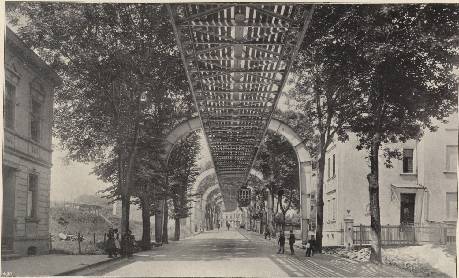
Abb. 65. ELEKTRISCHE SCHWEBEBAHN BARMEN-ELBERFELD-VOHWINKEL, (System Eugen Langen . Der vierte Teil der Brücken und Stützen ausgeführt von der GESELLSCHAFT HARKORT IN DUISBURG am Rhein. (4000 T).
