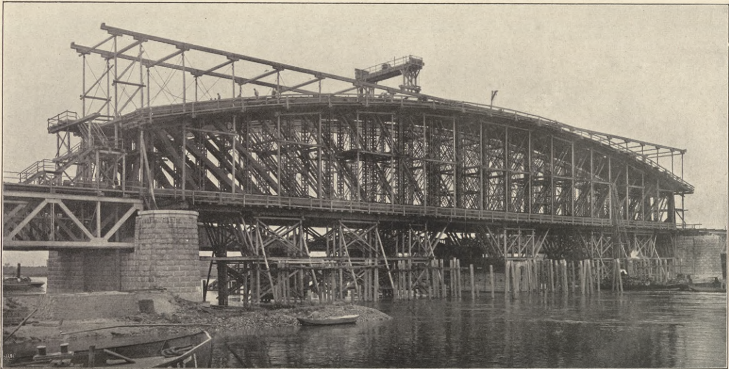
Abb. 53. EISENBAHN- UND STRASSENBRÜCKE ÜBER DIE YSSEL BEI WESTERVOORT-ARNHEIM, Linie Zevenaar-Arnheim. Ausgeführt 1899–1901 von der GESELLSCHAFT HARKORT IN DUISBURG am Rhein
