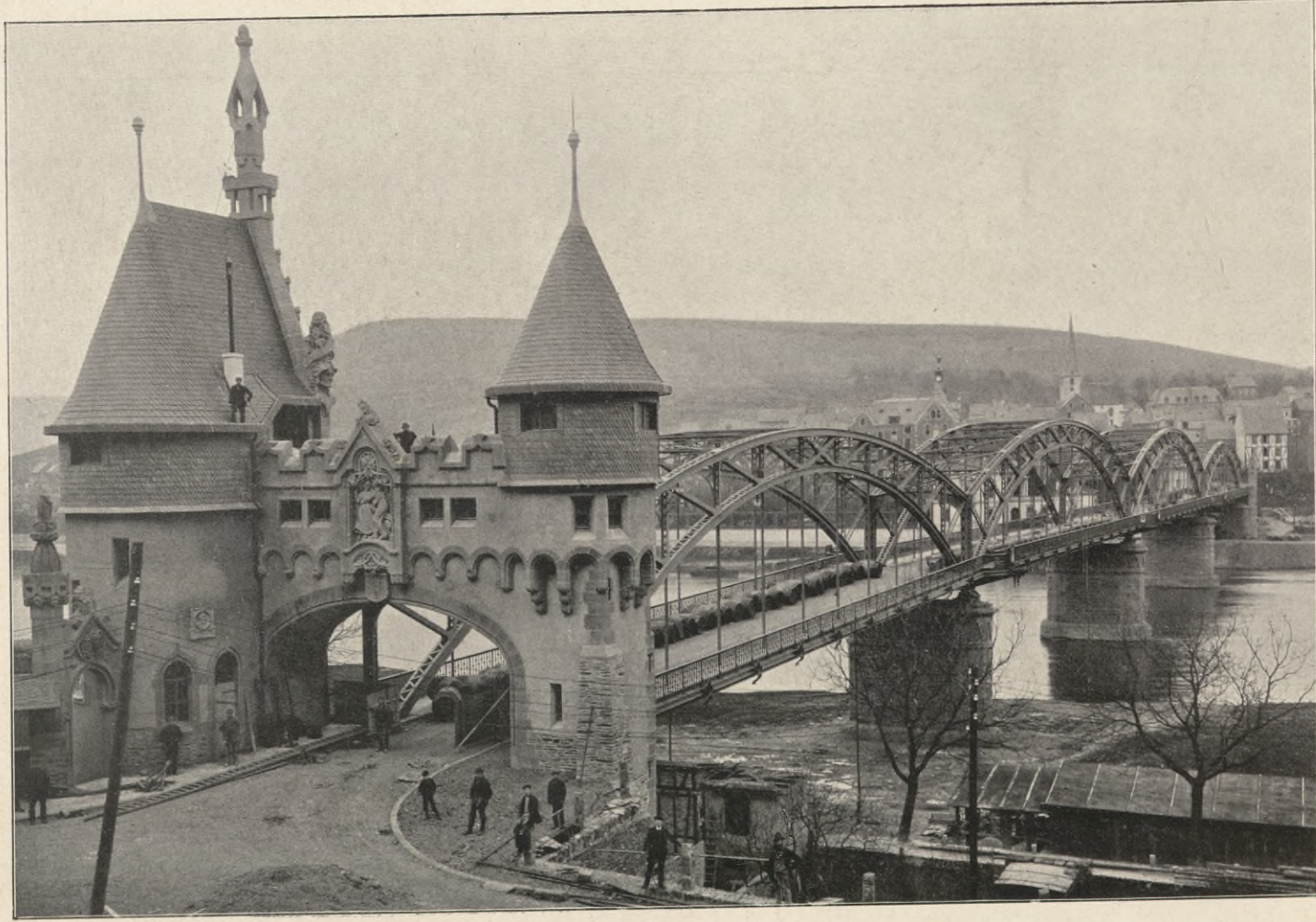
Abb. 54. BRÜCKE ÜBER DIE MOSEL BEI TRARBACH- TRABEN, Entworfen u. ausgeführt 1898—1899 von der GESELLSCHAFT HARKORT IN DUISBURG am Rhein, Bruno Möhring und R. Schneider in Berlin.
