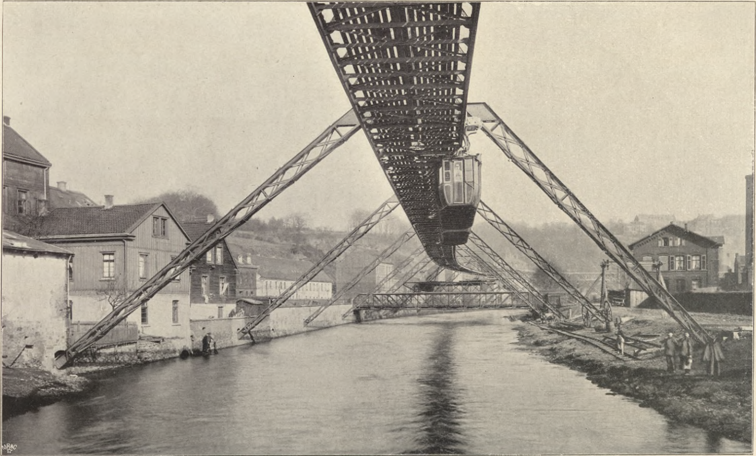
Abb. 64. ELEKTRISCHE SCHWEBEBAHN BARMEN-ELBERFELD-VOHWINKEL, (System Eugen Langen). Der vierte Teil der Brücken und Stützen ausgeführt von der GESellschaft HARKORT IN DUISBURG am Rhein. (4000 T).
