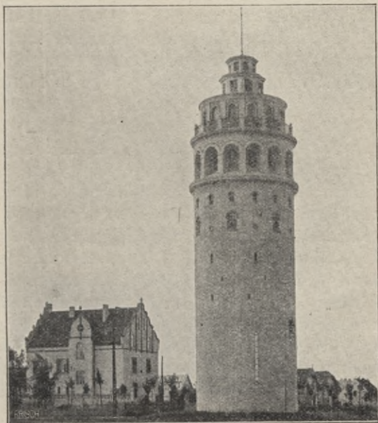
Bild 17. Wasserturm in Niederlehme.
