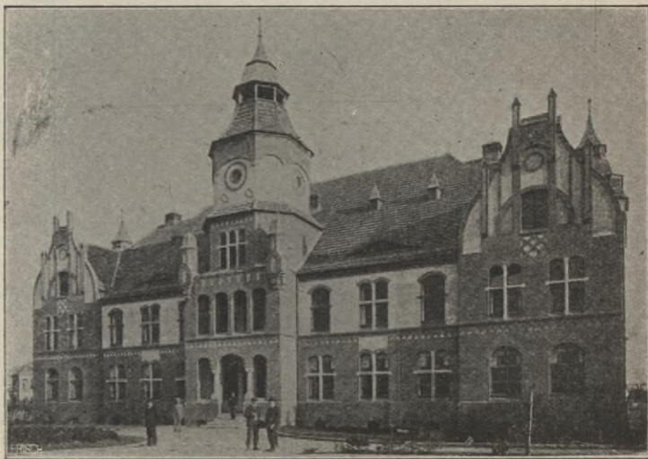
Bild 8. Krankenpavillon in Wik bei Kiel.
