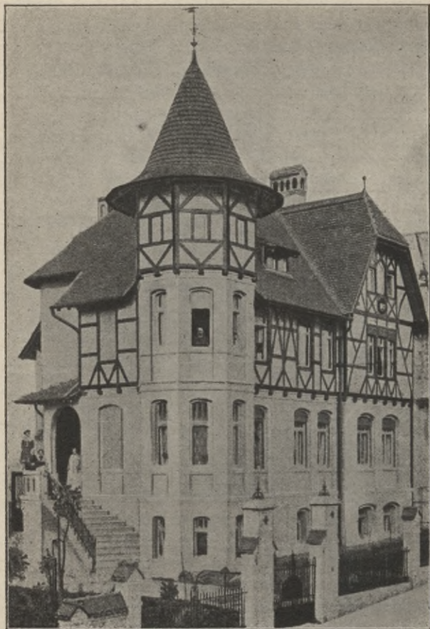
Bild 10. Kalksandsteingebäude in Halle a. S., Tiergartenstraße.
