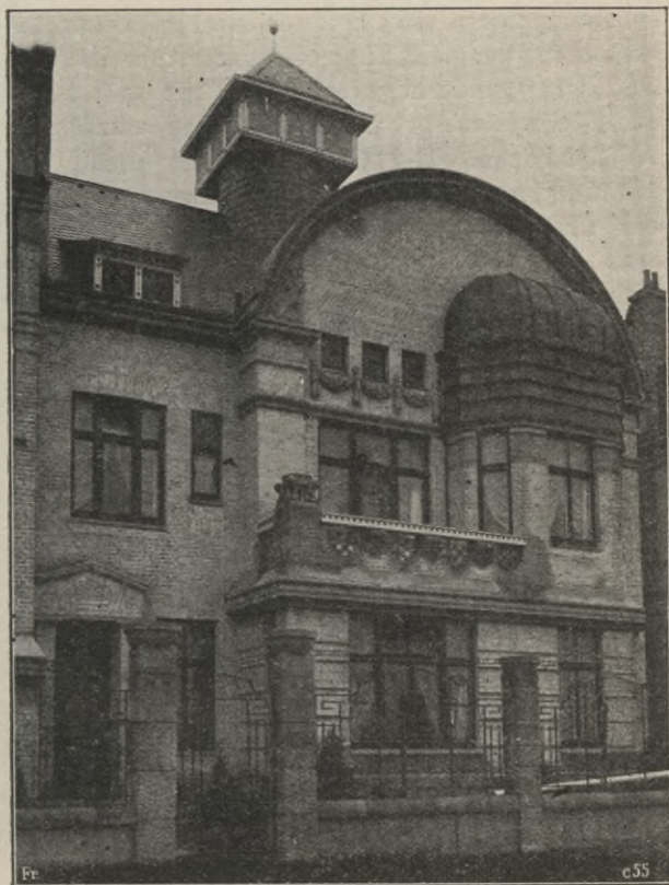
Bild 6. Kalksandsteinbau in Lehe mit vom Bildhauer bearbeiteten Kalksandsteinblöcken.
