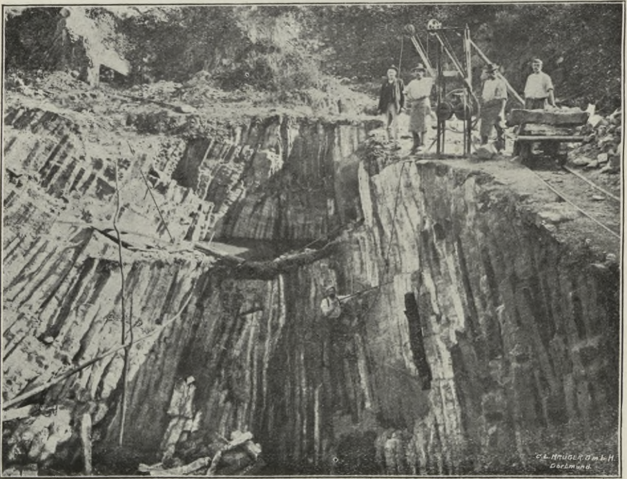
Fig. 18: Basaltbruch Oberwambach von Gebr. Uhrmacher in Obercassel (Siegbkreis). Unregelmäßige Säulen in meilerartiger Stellung.
