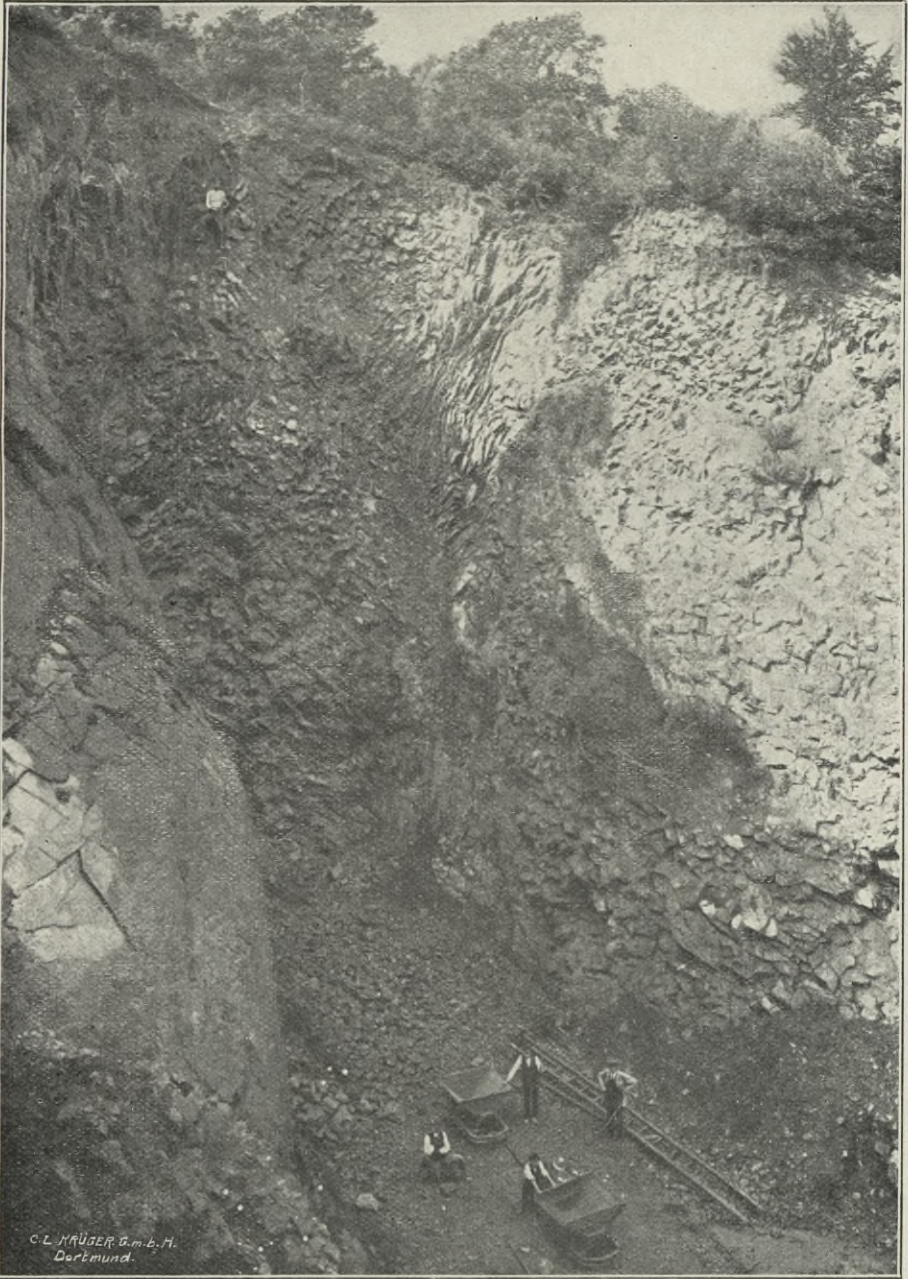
Fig. 25: Basaltbruch kl. Oelberg von Gebr. Uhrmacher in Obercassel (Siegkreis). Fester Basalt mit schiefrigen Bruchflächen. Die Bewegungen des Basaltstromes sind noch erkennbar. Links durch Kontaktmetamorphose in harten Tonschiefer verwandelte Lehmwand.
